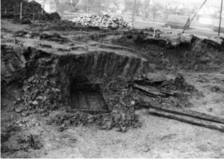
Abb. 3: Hüfingen „Gierhalde“. Baugrube mit den Resten von Kammergrab 1 nach Einstellung der Baggerarbeiten (Aufnahme: Archivar G. Goerlipp).
