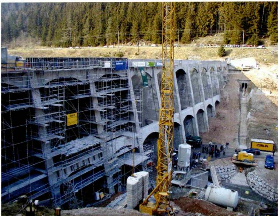
Betonsanierung der Luftseite (Stadtarchiv Vöhrenbach).
