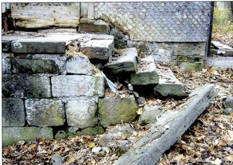
Nordfassade, Treppenaufgang rechts (Foto H. Sumser).
