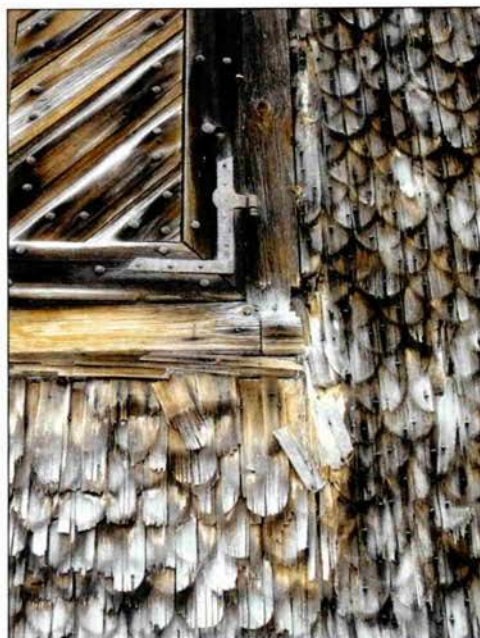
Detail Fassade (Foto H. Sumser).
