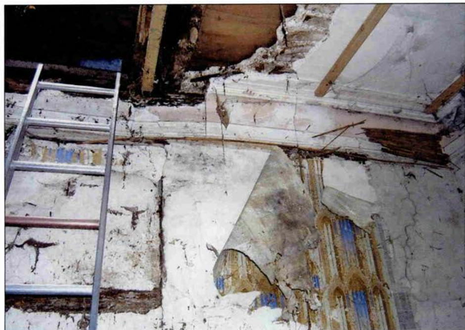
Innenraum, Deckenzone mit Tapetenrest (Foto H. Sumser).
