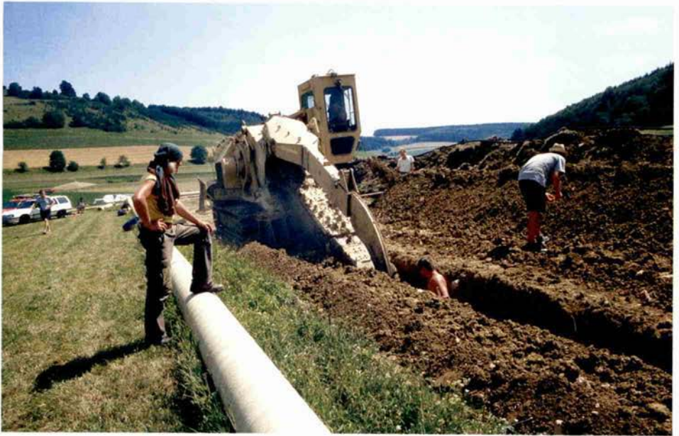
Abb. 2: Gasleitung Juli/August 2003. Gesamtsituation (Foto: Landesdenkmalamt Baden-Württemberg, Archäologische Denkmalpflege, Außenstelle Freiburg)
