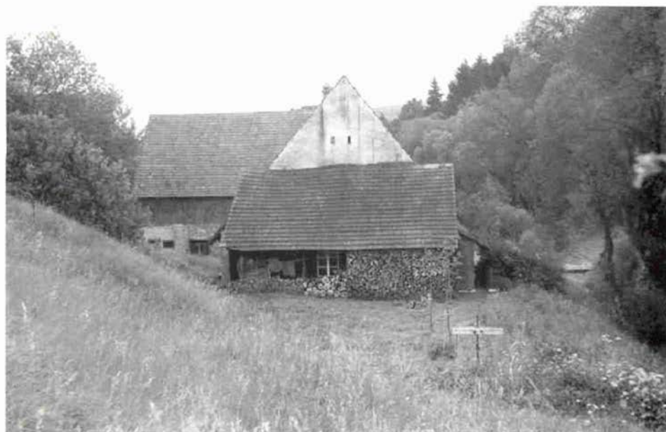
Abb. 7: Rückansicht der Guggenmühle 1974. Das abgeschleppte Dach des Maschinenschuppens verdeckt weitgehend den Giebel. Der kleine Anbau rechts ist das stille Örtchen. Im Vordergrund die Reste des Stellwehres im Mühlgraben.
