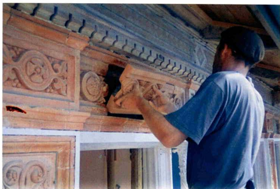
Abb. 8: Die neuen Stücke werden in Kalkspeis gebettet und von U. Esterle eingebaut
