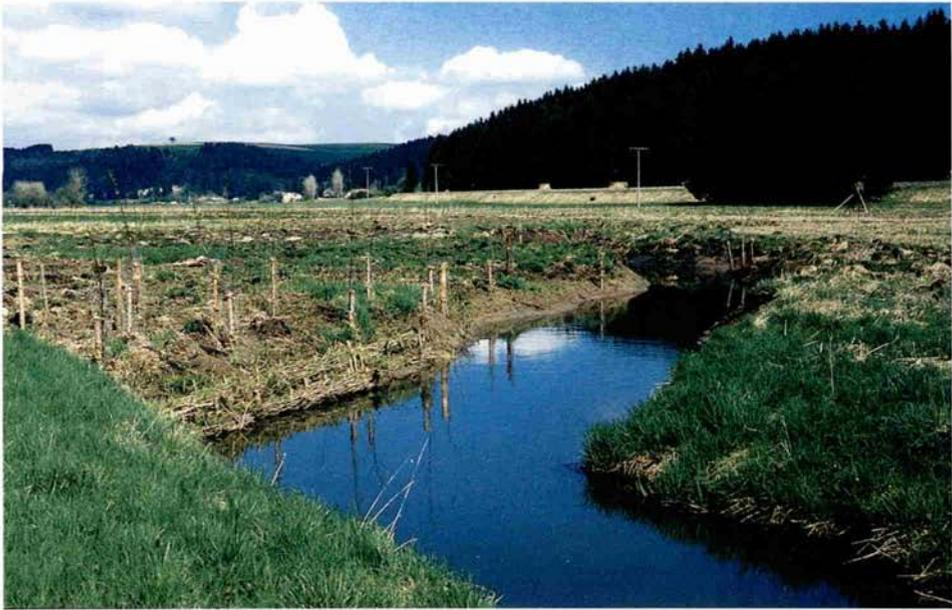
Abb. 5: (5.5.1996) Weidenfaschinen kurz nach dem Einbau.
