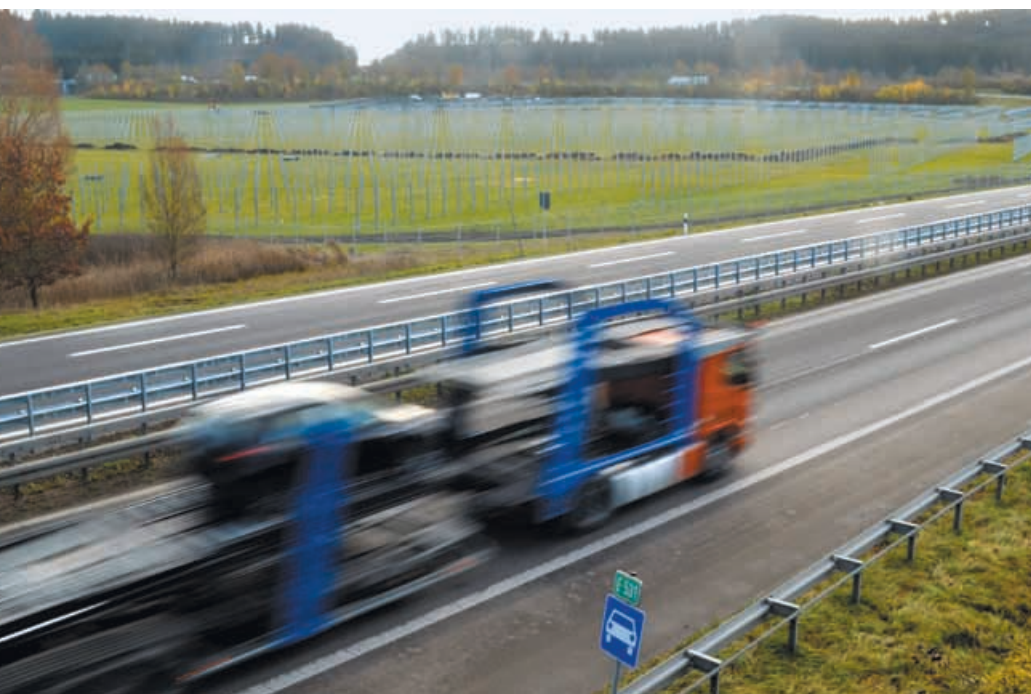
An der B33/27 entsteht die Agri-Photovoltaikanlage Donaueschingen-Aasen.
