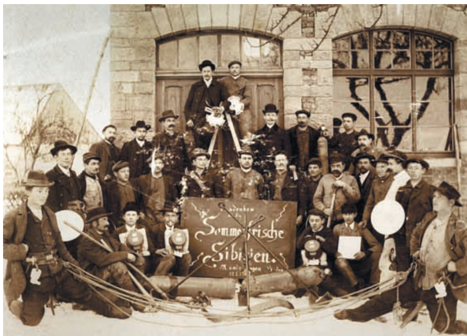
Bau der Sekundärstation in Mundelfingen am 12. Januar 1907.
