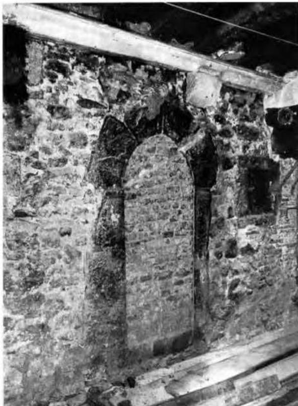
Abb. 15 Tor eines Hauses im Keller eines Anwesens in der Löwenstraße, schon in den 30er Jahren durch Ausbau gestört.
