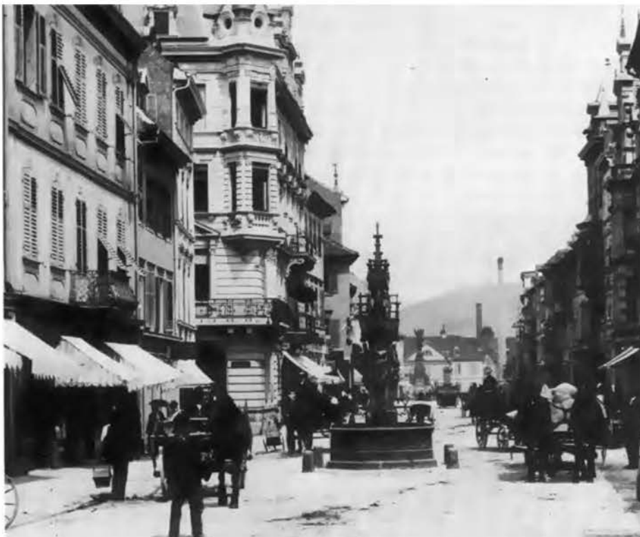
Abb. 3 Kaiserstraße 56 (Mitte links) mit Fischbrunnen
