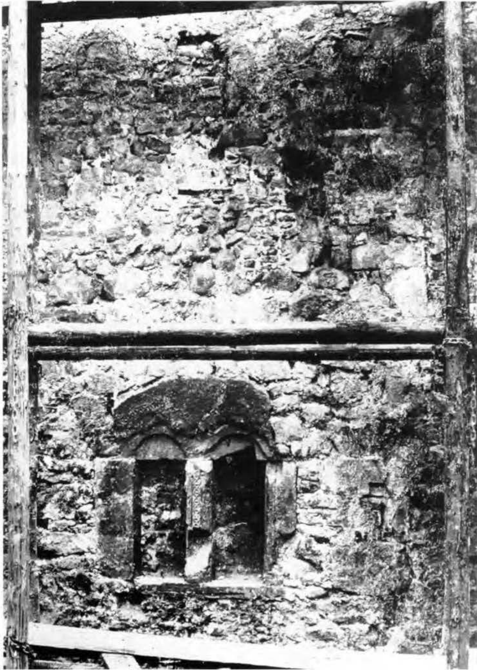
Abb. 4 Romanisches Fenster im Mauergefüge Augustinermuseum, D 98 a, Kasten 33
