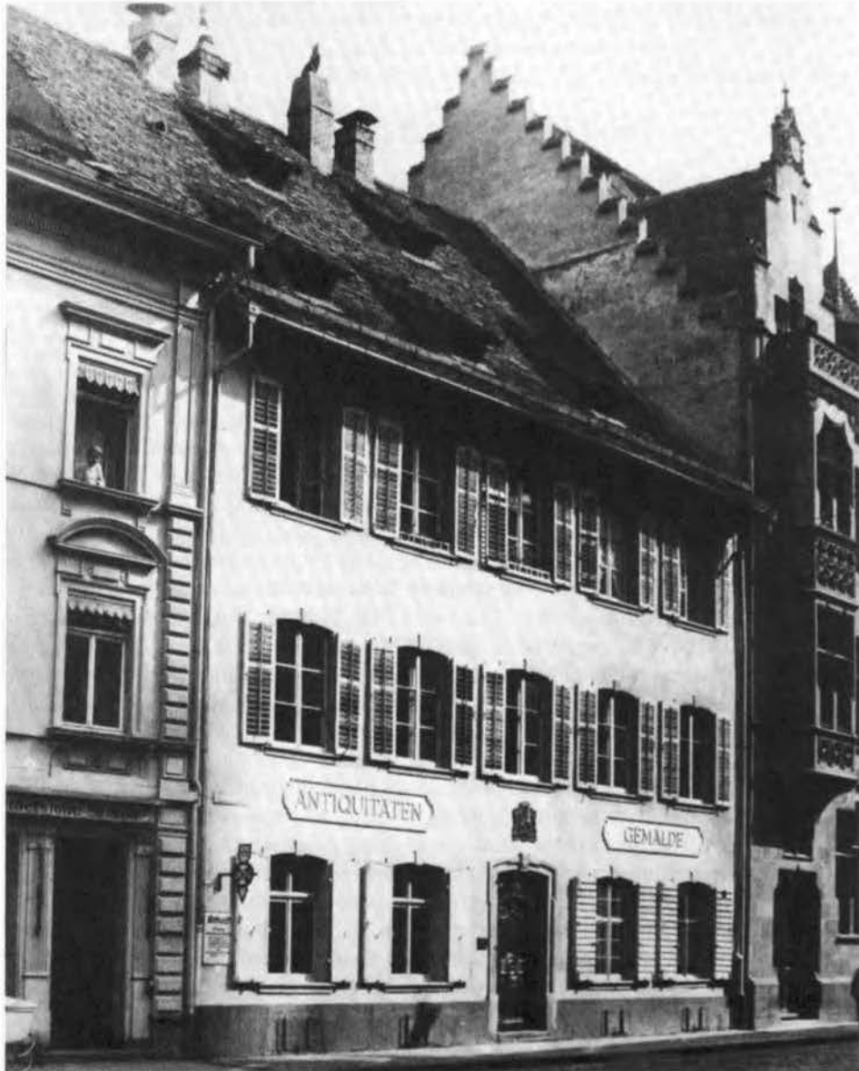
Abb. 1 Das nach 1900 entstandene Bild zeigt links den Eingang des Hauses Franziskanerstraße 11, rechts anschließend das Haus „zum Pilgerstab“ (Franziskanerstraße 9) und daneben einen Teil des ersten Bauabschnitts der Gewerbebank. Über der Tür das Wappen Abb. 2.
