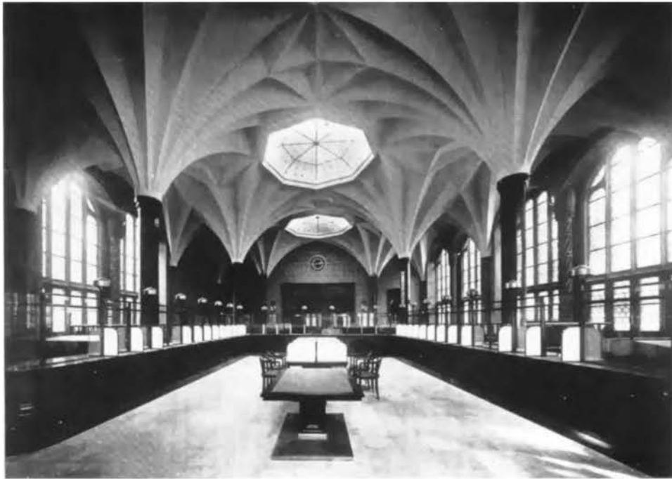
Abb. 5 Kassenhalle der Sparkasse nach dem Umbau.
