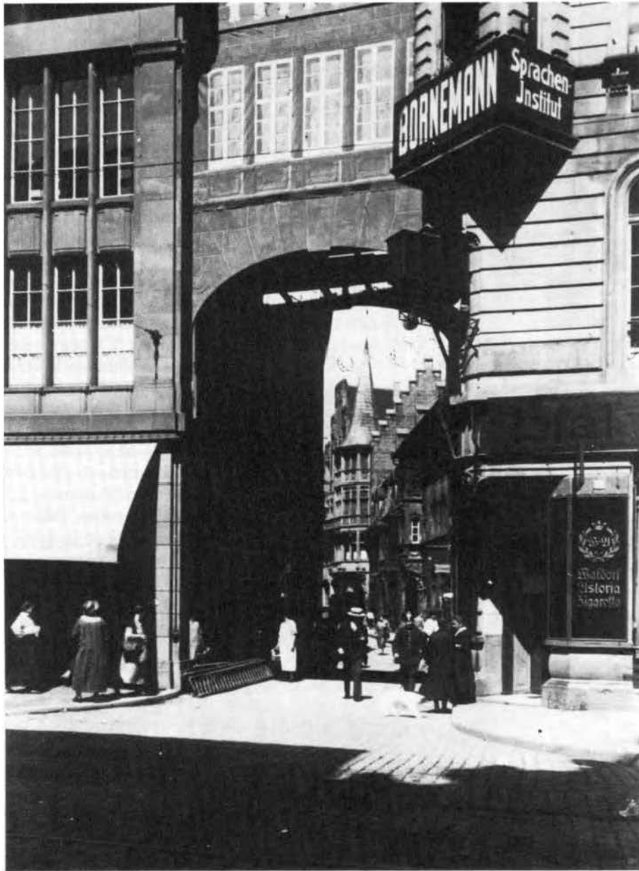
Abb. 6 1927 „in der Natur angebrachtes Modell“ aus Holz und Leinwand der geplanten Brücke über die Franziskanerstraße.
