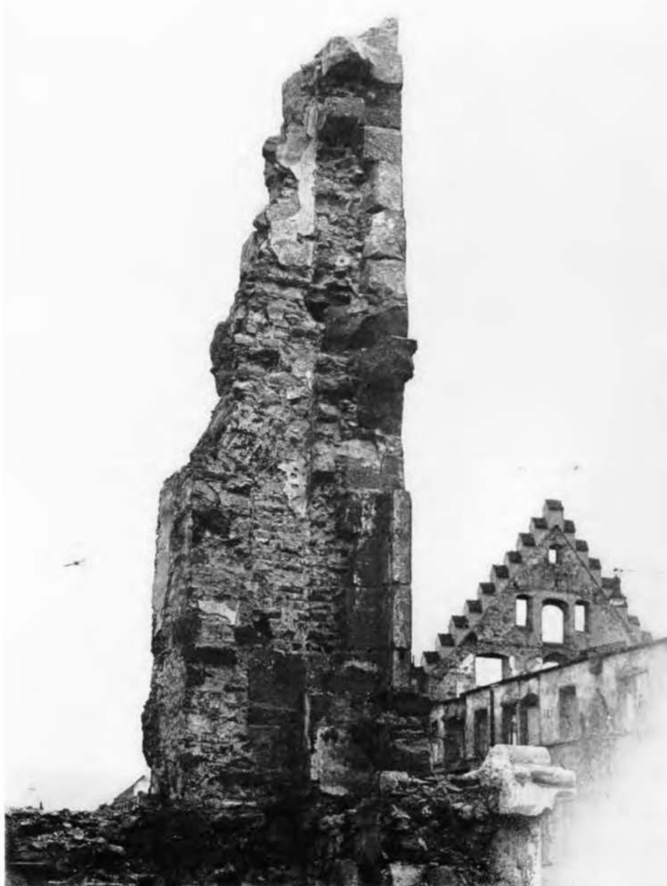
Abb. 3b Haus zum Gauch nach Zerstörung 1944. Unter Putz des 19. Jh. wird Bossenquaderwerk des 13./14. Jh. sichtbar. (Quelle: StAF M 7010 Kaiserstraße)
