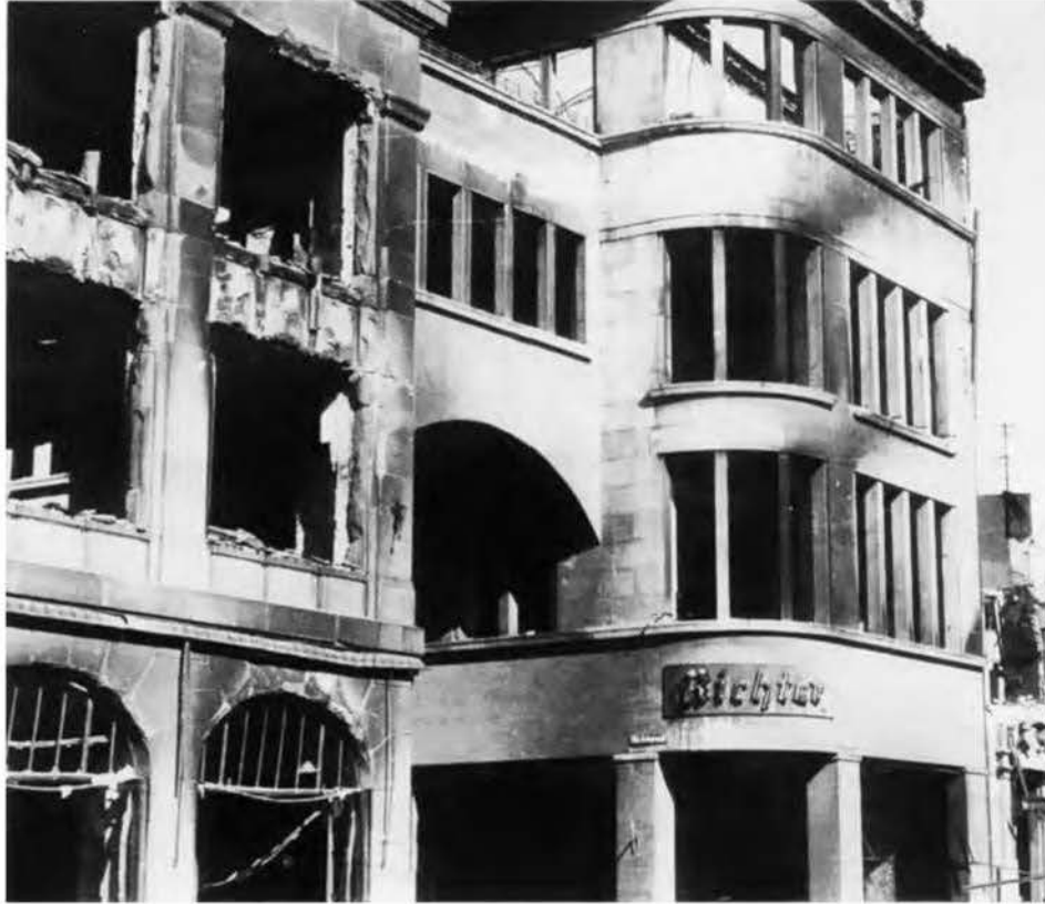
Abb. 7 Haus Kaiserstraße 56 in ausgebranntem Zustand nach dem Bombenangriff 1944.
