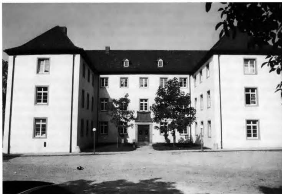
Abb. 2 Hofansicht nach der Instandsetzung 1977 – 1979.
