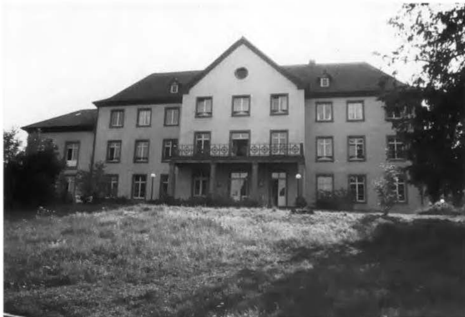
Abb. 1 Gartenfassade nach der Instandsetzung 1977 – 1979.
