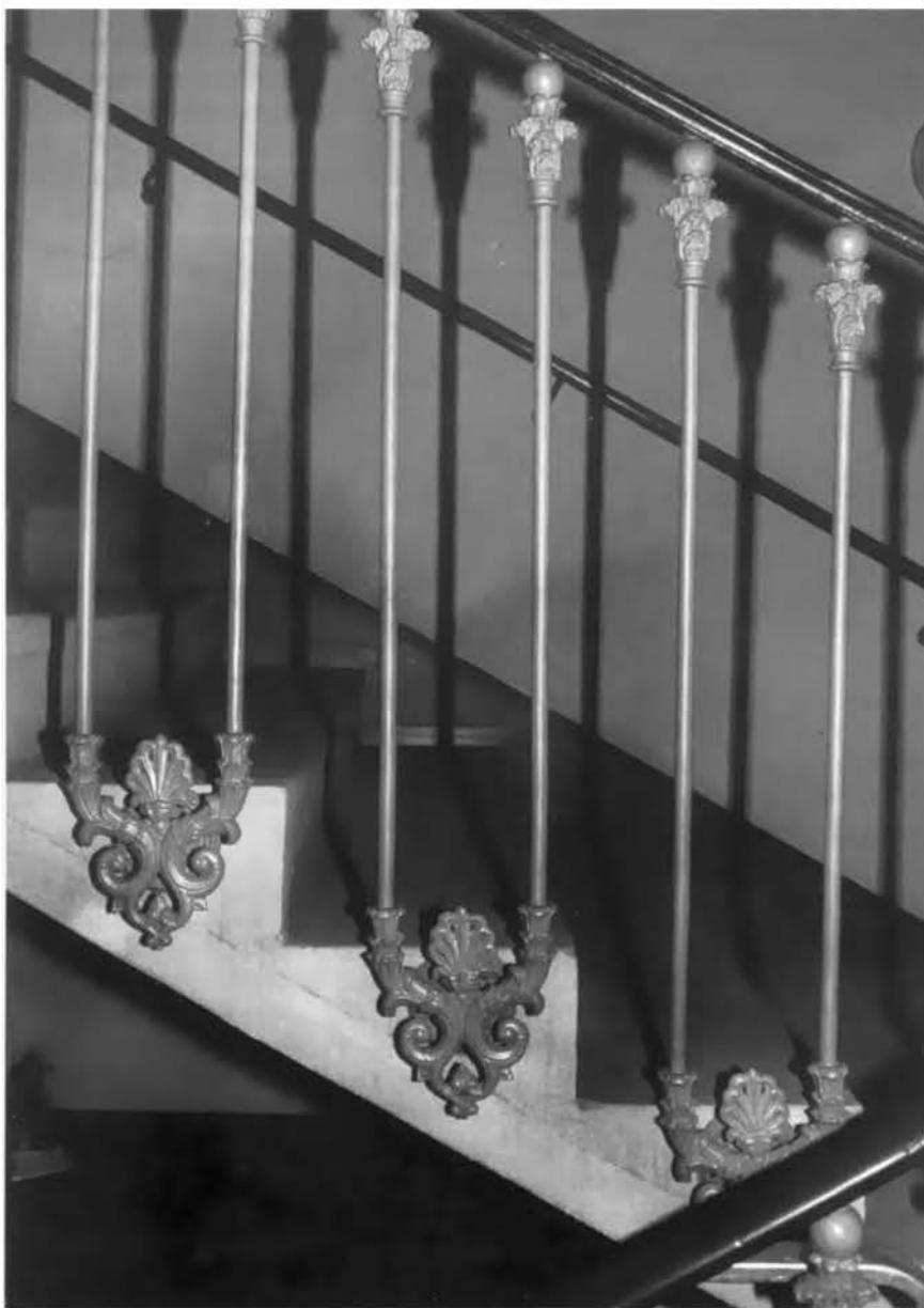
Abb. 14 Detail des Treppengeländers der 1900 eingebauten Treppe.
