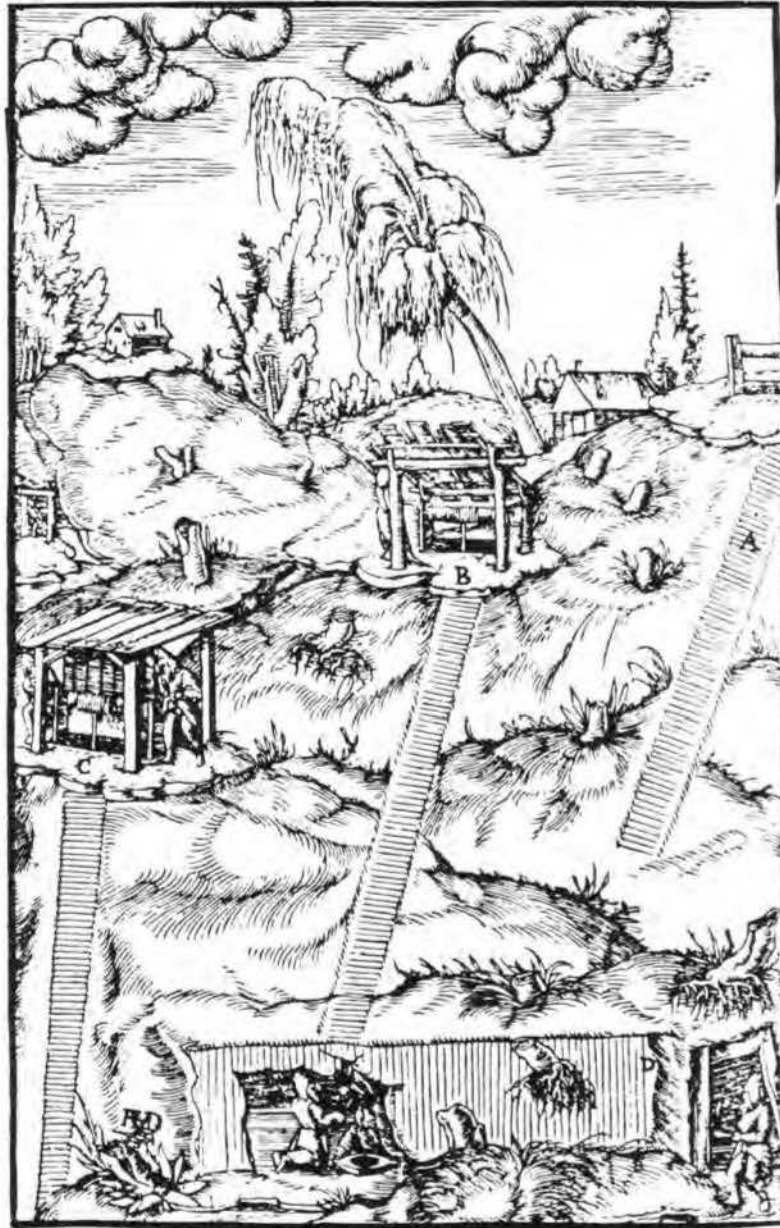
Abb. 1. Bergbau im 16. Jh. Nach Georg Agricola, De re metallica 1556. Wichtige technische Fortschritte waren im 13. u. 14. Jh. gemacht worden, wie der Einsatz von Wasserkraft zur Beförderung von Menschen, Erzen und Grubenwasser. Dem Knappen jedoch blieb die mühevoll Handarbeit mit Schlägel, Setzeisen und Eisen bei Fackelbeleuchtung in halbliegender Stellung nicht erspart.
