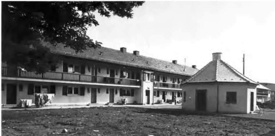
Innenhof der Siedlung am Laubenweg, einem typischen Objekt des sozialen Wohnungsbaus in den 20er Jahren.
