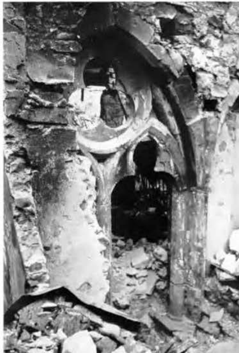
Abb. 7 Ostecke der nördlichen Kreuzgangswand.
