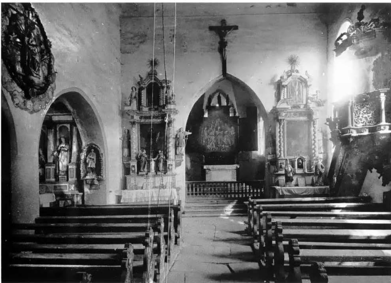
Zustand des Kircheninnern vor dem I. Weltkrieg — Historische Aufnahme, Landesdenkmalamt Karlsruhe, Neg. Nr. 04769.
