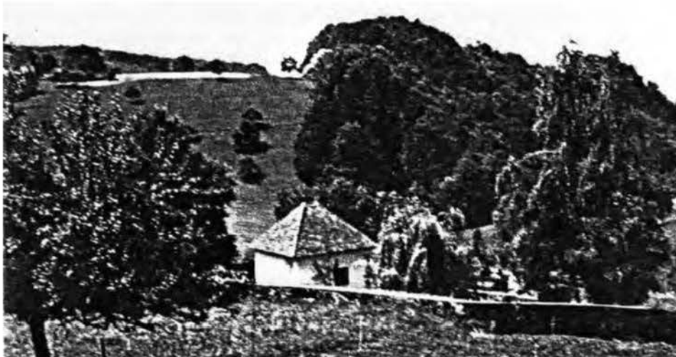
Blick über die noch stehende Sakristei der alten Kirche in den bei der Überschwemmung vom Wasser aufgefüllten Talkessel. Aufnahme des Verfassers.
