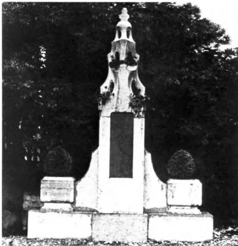
Abb. 2 Hermann Obrist, Grabmal Toporski auf dem Hauptfriedhof Freiburg im originalen Zustand von 1912 (Aufnahme 1914).
