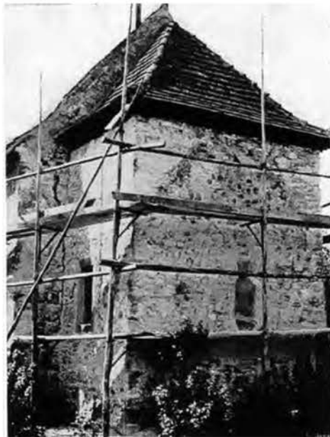
Abb. 1 Glöcklehofkapelle, freigelegte Ostwand
