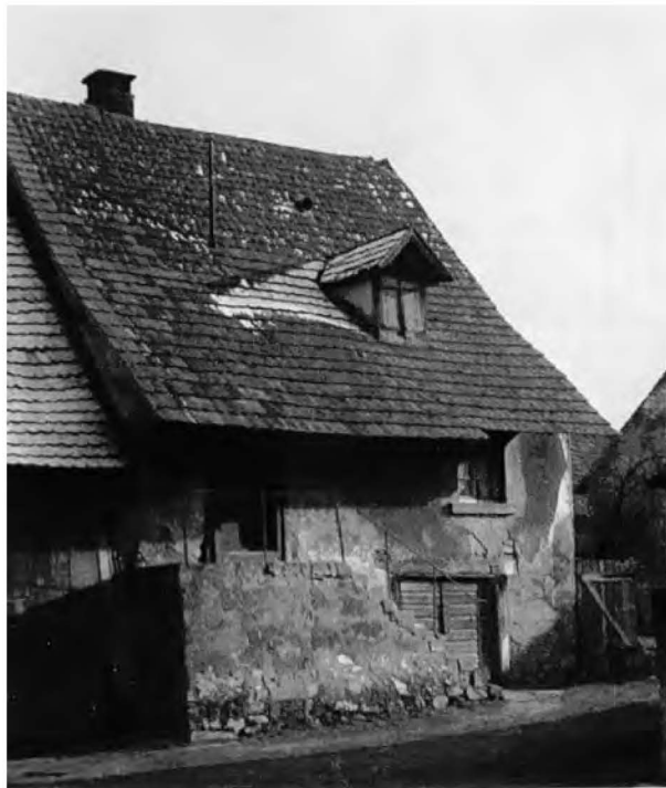
Abb. 2 Gottenheim Waltershofer Straße 1 (Lg 106, 1780): Typische Höherlegung der Wohnräume, bedingt durch die am Tuniberg übliche Unterkellerung.
