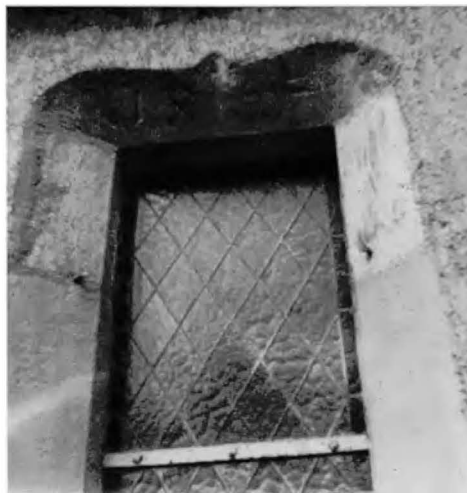
Abb. 4 Kirche Hügelheim. Ostfenster der Turmhalle, ehemals Chor (1492).
