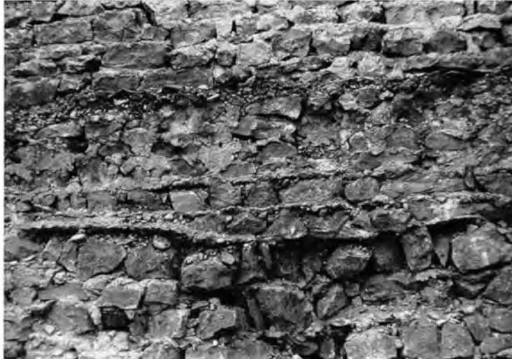
Abb. 4 Opfingen (Lg 119): Bruchsteinbau aus spärlich miteinander verkitteten Kalksteinen.
