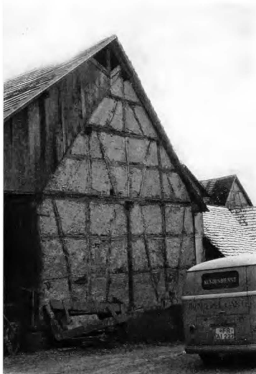
Abb. 3 Opfingen Haus 188 (Lg 112, 1754): Fachwerkbau mit dreifach stehendem Stuhl. Herkunft aus der Firstsäulenkonstruktion deutlich erkennbar.
