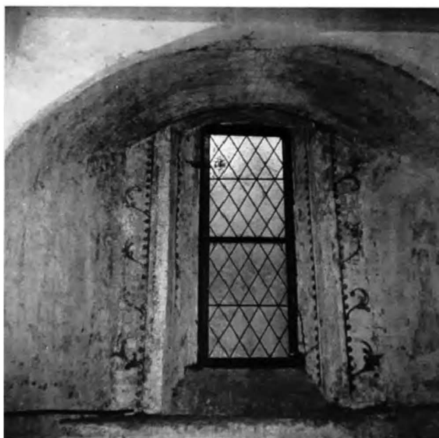
Abb. 3 Kirche Hängelheim. Fenster in einer Nische der Turmhallenostwand.
