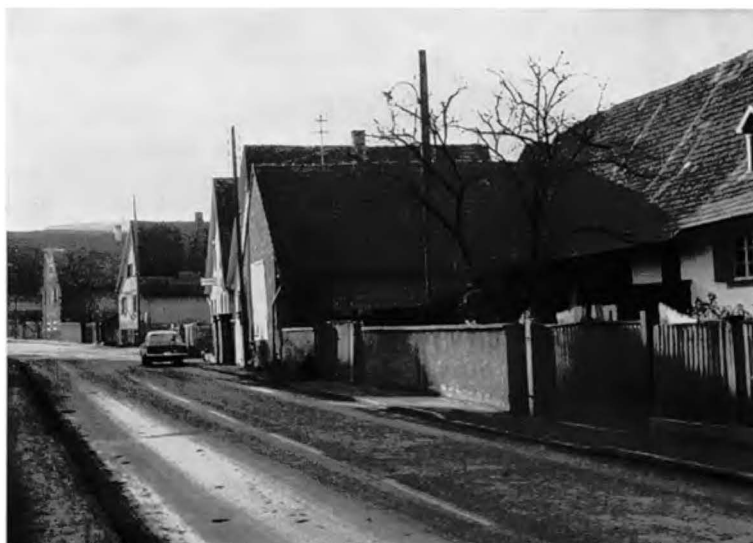
Abb. 1 Gottenheim Hauptstraße. Giebelseitige Stellung der Gebäude.
