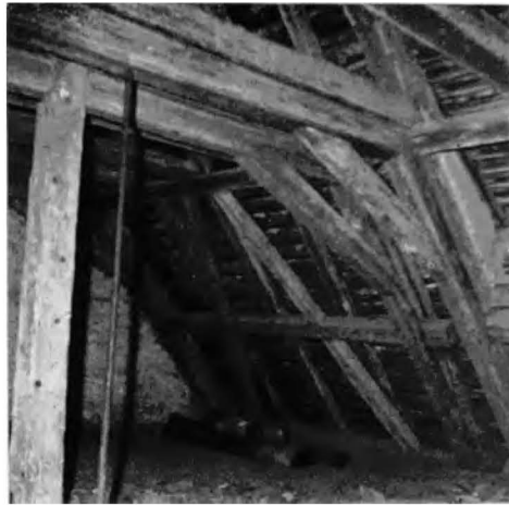
Abb. 2 Kirche Hügelheim. Abgesetzter Dachstuhl über der Verlängerung des Langhauses (1746).
