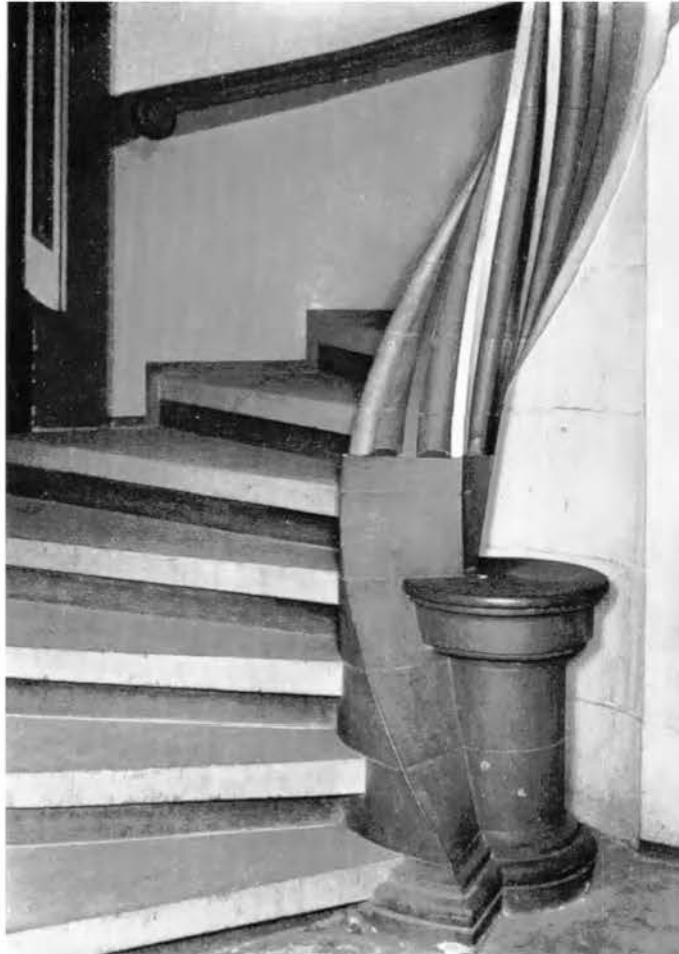
Abb. 14 Fuß der Treppenspindel (1496).
