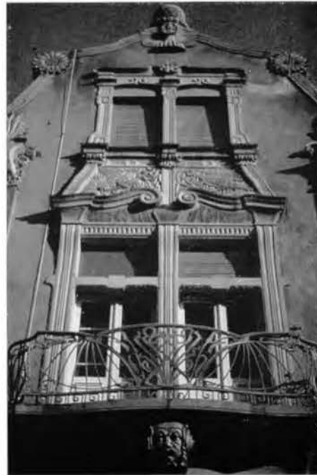
Abb. 6 Fassadengestaltung am Haus Tivolistraße 15, 1901.
