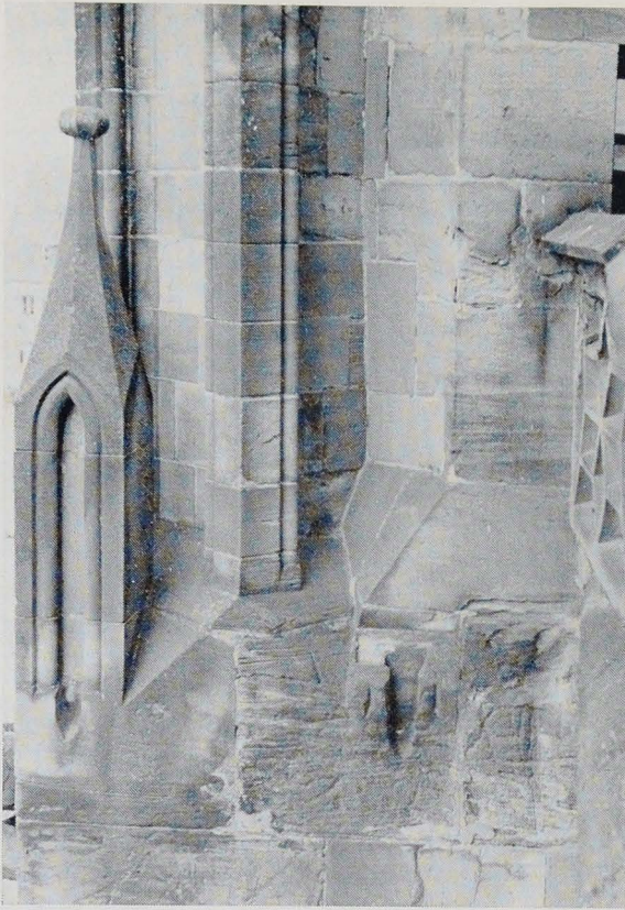
Abb. 1 Freiburg: zweiter nordöstl. Strebe Pfeiler, Detail
