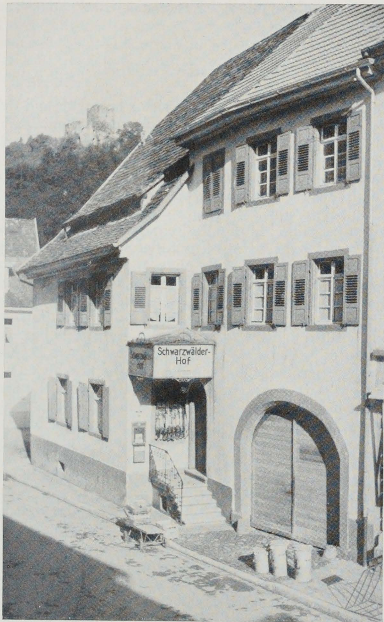
Abb. 2 Ehemaliges Merzsches Amthaus, jetzt Gasthaus zum „Schwarzwälder Hof“, Engelstraße 5. Der Torbogen ist alter Bestand. Er gehörte ursprünglich zur vorderen Scheuer. Die breite Schleppegaube stammt aus der 1710 dort eingerichteten Rotgerberei. (Foto-Müller, Waldkirch)
