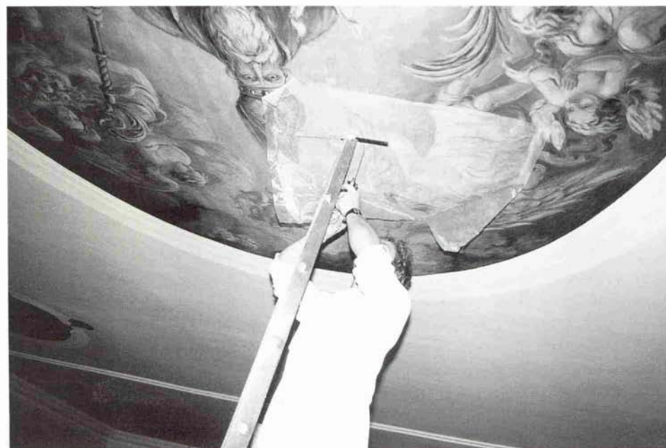
Abb. 3: Die mit einem Vlies laminierte Hohlstelle wird mit Kalkaseinkleber hinterspritzt
