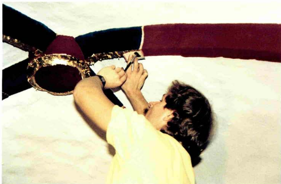
Abb. 9: Anschließen der Blattgoldauflage am Schlußstein
