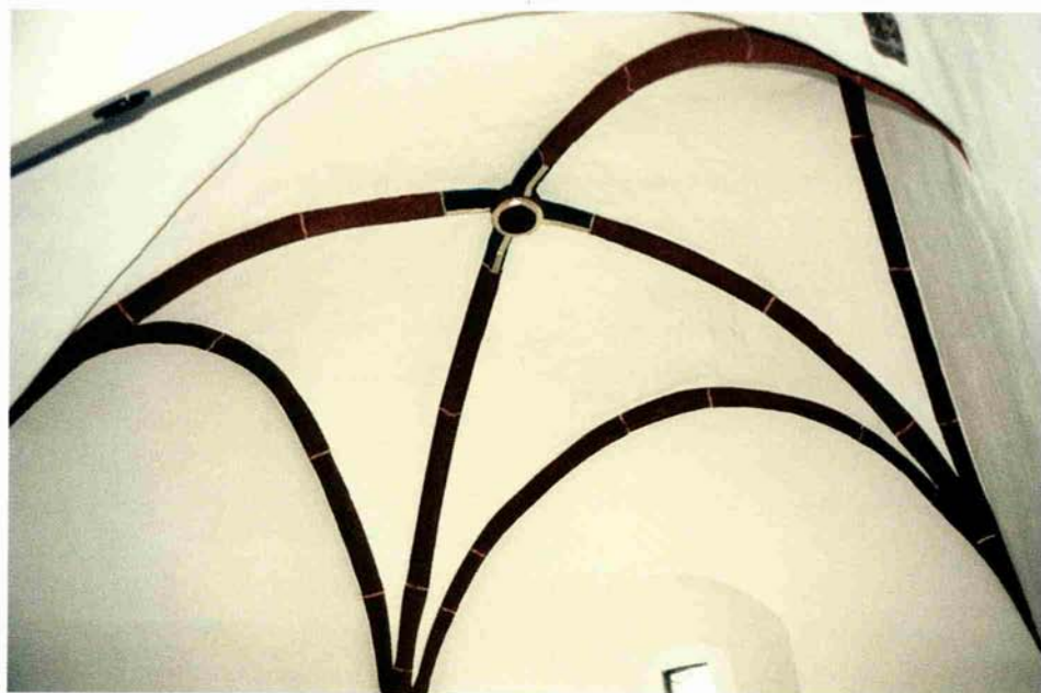
Abb. 10: Kreuzrippengewölbe nach der Restaurierung
