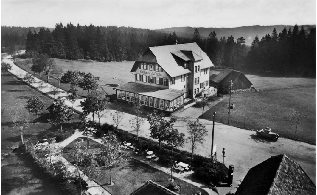
Bild 6: Die „Zuflucht“ Anfang der 1930er Jahre. Diesseits der Straße war zwischenzeitlich eine gepflegte Gartenwirtschaft entstanden. Die geräumige Glasveranda – in der Wintersaison als Skistall genutzt – kam schon 1911 hinzu (vergl. Bild 5). Leider fiel das zierende Aussichtstürmchen auf dem Dach der „Zuflucht“ (vergl. Bild 5) den Umbaumaßnahmen zum Opfer.
