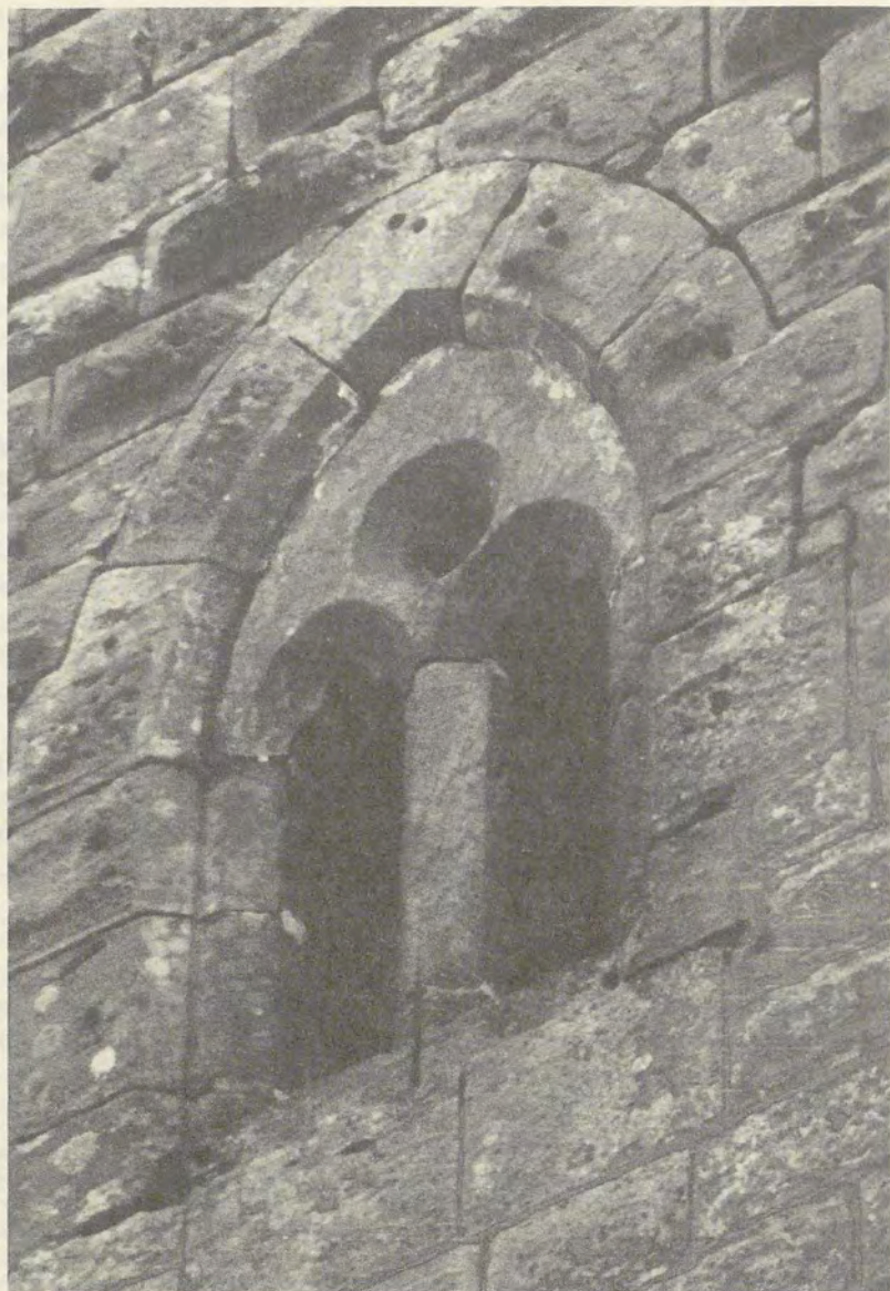
Abb. 8: Wasenburg bei Niederbronn-les-Bains. Wohnbau, Nordwand, 1. Obergeschoß, Fenster (vor 1272). (Foto Th. Biller 1977)
