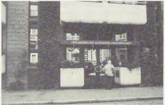
Abb. 13: Basel (Feierabendstr. 1) Ökumenisches Altersheim Hasenbrunnen. 1977
