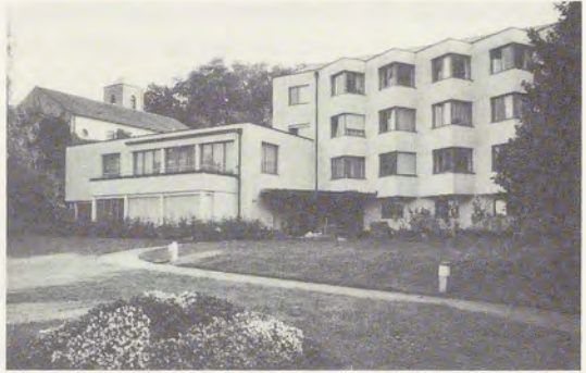
Abb. 12: Oberwil, Kt. Baselland. Ev.-ref. Gemeindesaal mit Altersheim (Johanneshaus). 1964
