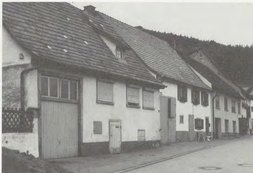
Abb. 7: Tagelöhnerhäuser-Zeile in Aulfingen, baulich stark verändert
