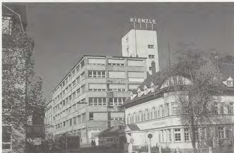
Foto 3: In der Nähe des Schwenninger Bahnhofs entwickelte sich beidseits der Friedrich-Ebert-Straße das Stammwerk der Kienzle-Uhrenfabriken. Nach Auslagerung der Produktion in einen Neubau werden die dargestellten Altgebäude von der Fachhochschule Furtwangen bzw. der Städtischen Galerie genutzt. Aufnahme: 1995.
