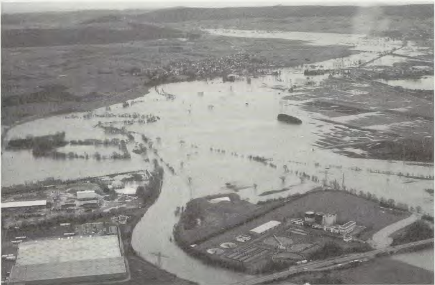
Abb. 14: Die eingedeichte Donau im Überschwemmungsgebiet der Riedbaar bei Donaueschingen, 27.01.1995. Der Retentionsraum wird eingeengt durch Gewerbebetriebe (links) und Kläranlage (rechts)
