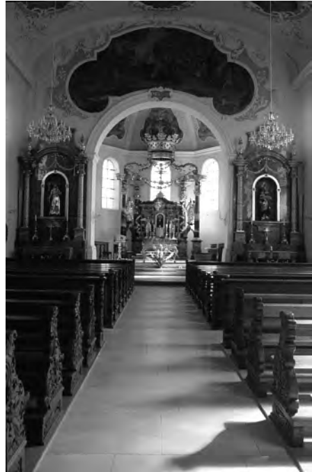
Abb. 15: Frick/CH, Pfarrkirche St. Peter und Paul. Tonnengewölbtes Langhaus und polygonal schließender Chor gegen Osten. Das Raumerlebnis, das vom warmen Kolorit der Fresken und den qualitätsvollen Régence-Stuckaturen bestimmt wird, kulminiert im Hochaltar. Der zwischen 1740 und 1750 errichtete Säulenbau legt Zeugnis für die Innovationskraft spätbarocker Inszenierungskunst ab. Foto: Patrick Bircher
