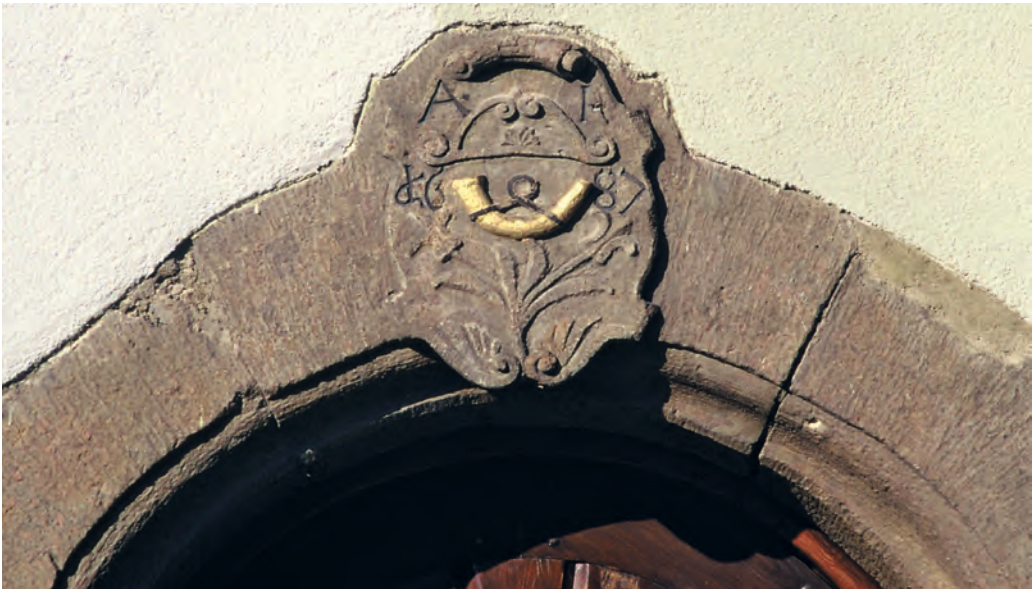
Abb. 9: Türrahmen des ehemaligen Postgebäudes in Burkheim. Relief aus Tephrit-Aschentuff. Objektbreite etwa 1,5 m. Foto: W. W.
