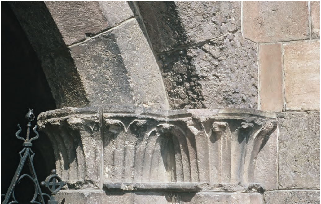
Abb. 5: Kapitelle aus Tephrit-Aschentuff am Unterchor des Breisacher Münsters. Darüber, am Ansatz eines Bogens, zwei stark angewitterte Stücke aus Tephrit-Pyroklastit. Objektbreite etwa 1 m. Foto: W. W.
