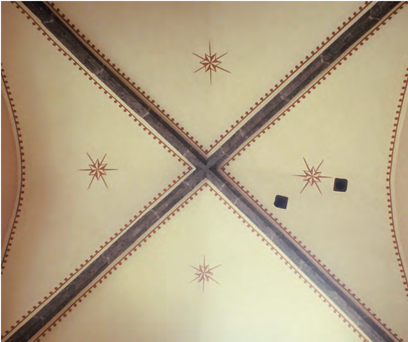
Abb. 19: Das Kreuzgewölbe der Vorhalle der Kirche in Baltzenheim. Die Rippen bestehen aus Tephrit-Pyroklastit. Foto: W. W.
