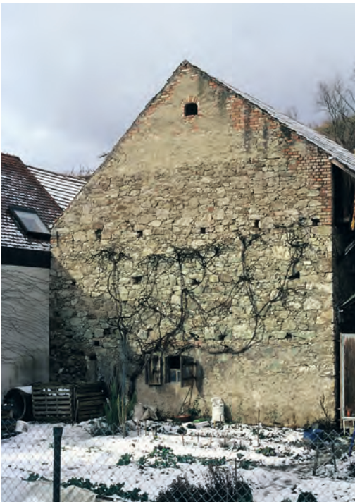
Abb. 16: Mauerwerk aus Karbonatit an einem alten Wohnhaus in Schelingen. Foto: W. W.
