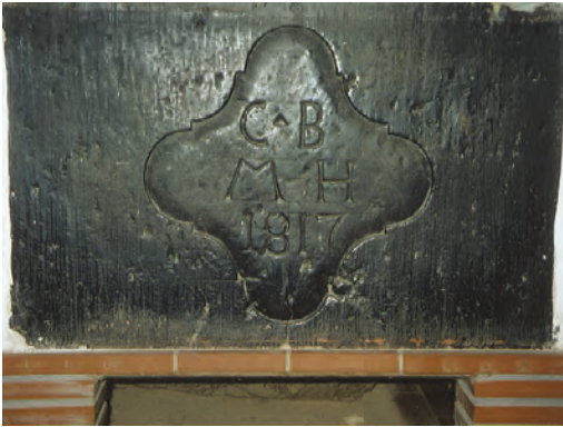
Abb. 22: Ofenplatte aus Tephrit-Pyroklastit, Eichstetten; Breite 72 cm. Foto: W. W.
