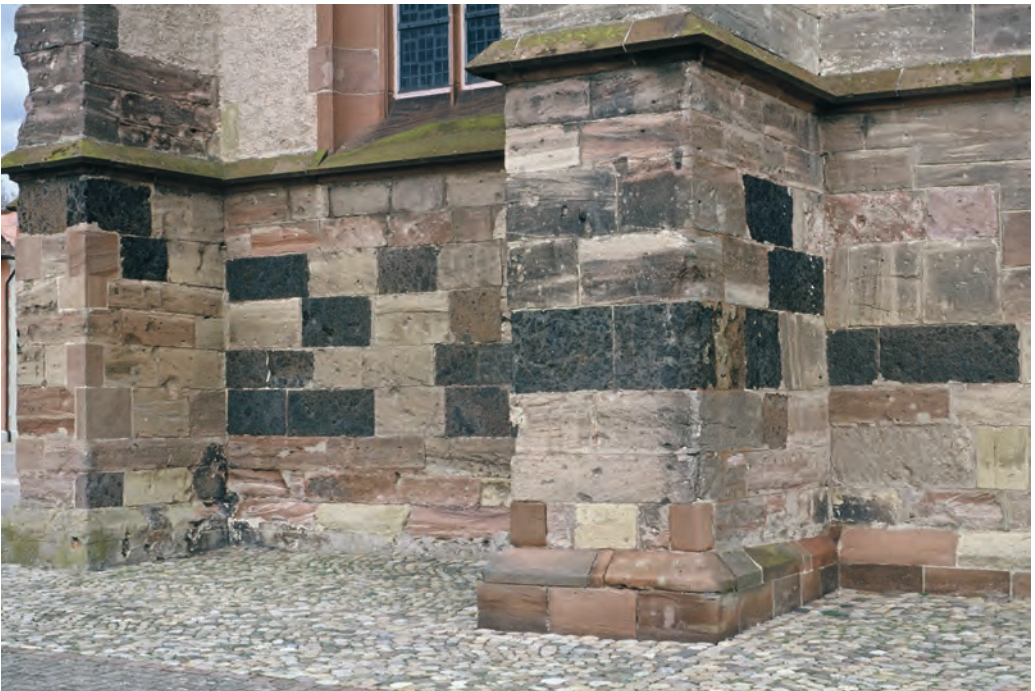
Abb. 3: Mauerwerk an der Westfront des Breisacher Münsters. Quader aus Sandstein und aus dunklen Tephrit-Pyroklastiten. Foto: W. W.
