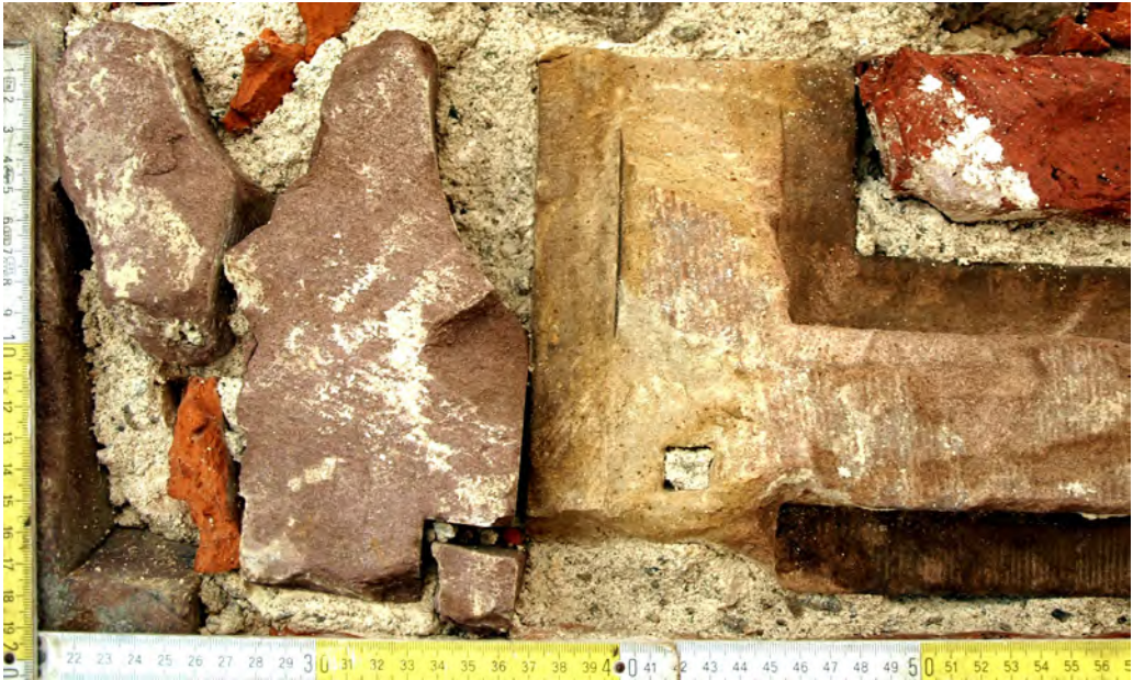
Abb. 14: Als Baumaterial wiederverwendete Werksteine (Gewändestücke) in der barocken Zusetzung der spätgotischen Fensteröffnungen. Foto: Frank Löbbcke, 2010.
