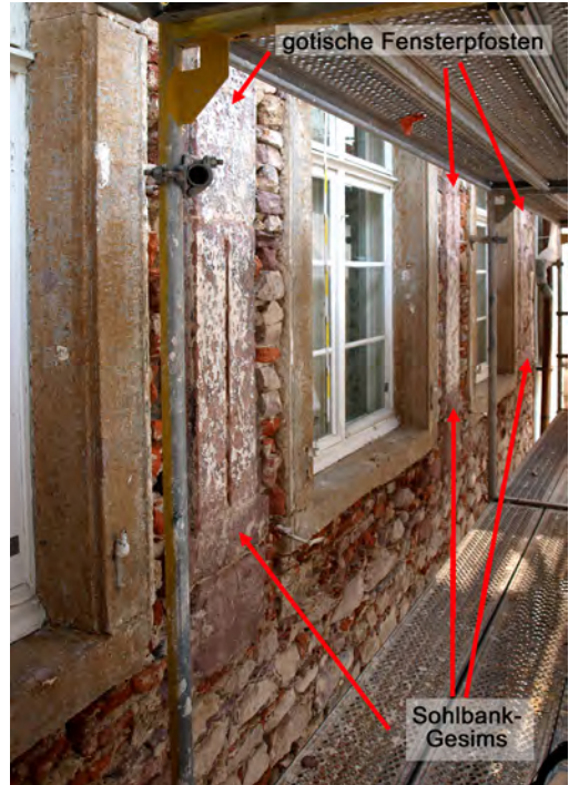
Abb. 9: Straßenfassade des „Hinteren Kaufhauses“ (Haus C), Fenster des Obergeschosses mit spätgotischem Fenstergewände auf ehemals vorspringendem Gesims. Foto: Frank Löbbbecke, 2010.
