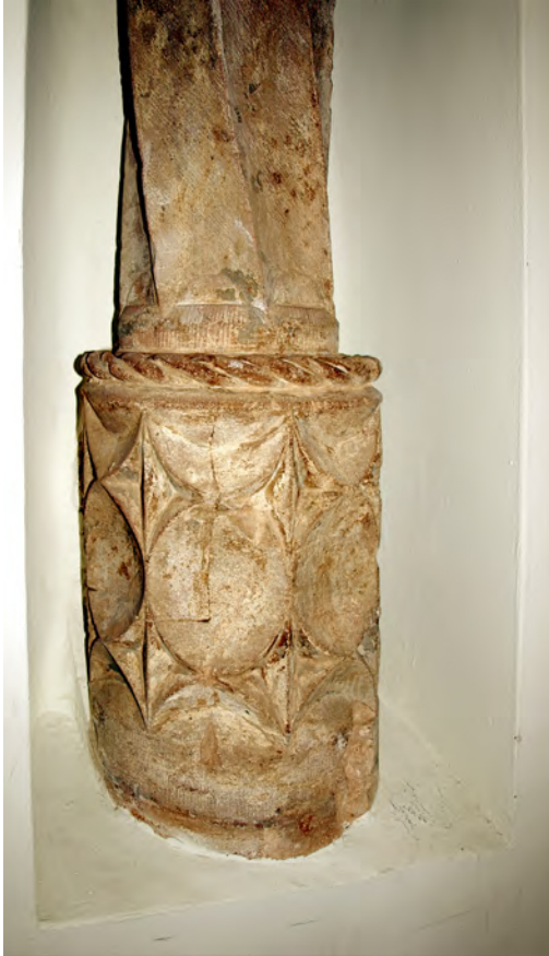
Abb. 10: Freigelegter spätgotischer Pfeiler zwischen den ehemaligen Fensternischen im westlichen Saal, Obergeschoss des „Hinteren Kaufhauses“. Foto: Frank Löbbbecke, 2010.
