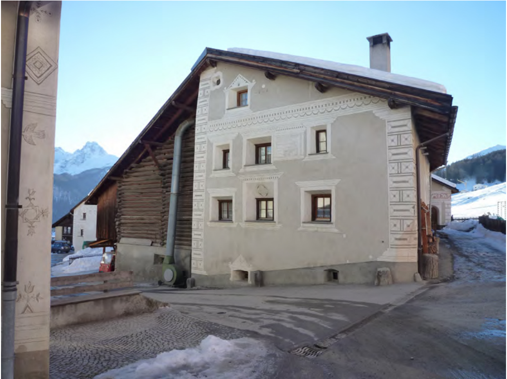
Abb.10: Vielzweckbau. Wohnteil gemauert und mit Sgraffito Ornamenten dekoriert. Ökonomieteil in Blockbau. Ftan, Sura Bügl 32, 17. Jahrhundert. Foto: Benno Furrer, 2011.
