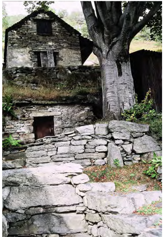
Abb. 9: Wohnhaus, Kaltkeller und Terrassierung in Bruchsteinmauerwerk. Nutzung des steilen Terrains unter Verwendung lokaler Baumaterialien mit beispielhafter handwerklicher Umsetzung der Bauaufgabe. Mergoscia, Bresciadiga. Foto: Benno Furrer, 2003.
