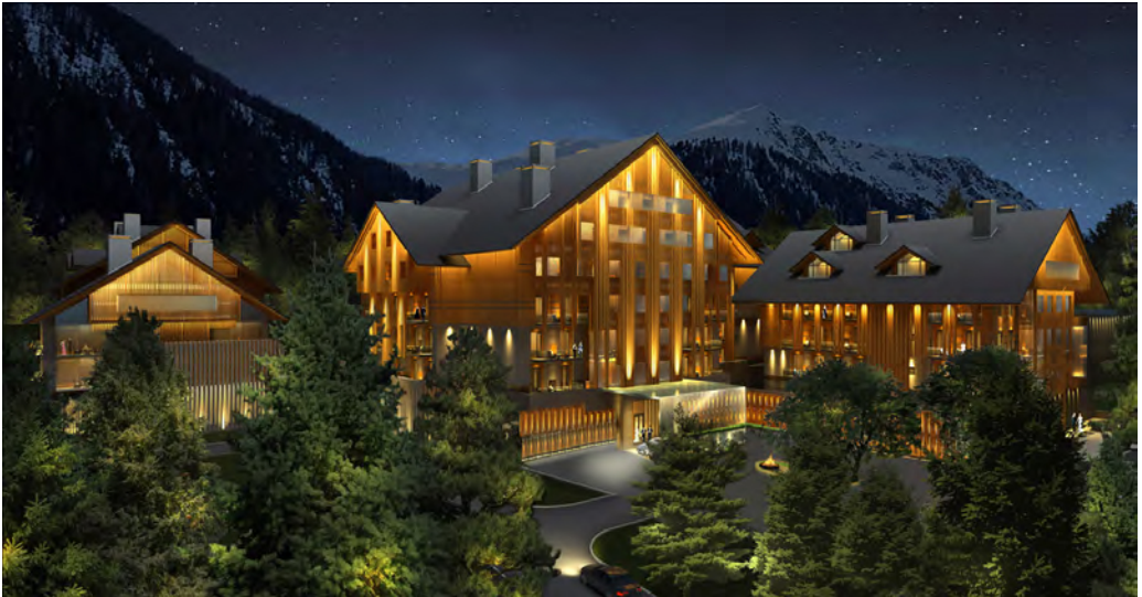
Abb. 16: The Chedi, Andermatt. Im neu entstehenden Ferien-Resort des ägyptischen Investors Samih Sawiris erfolgte am 10. November 2011 das Richtfest für das Fünfsternehotel Chedi. Denniston International Architects and Planners Ltd. haben das „Alpenjuwel“ geplant, welches sich – laut Verkaufsdossier – dank des Architekturkonzeptes harmonisch in die Umgebung einfügt. Das ambitionöse Projekt wird in Zusammenarbeit mit den lokalen Architekten Germann & Achermann aus Altdorf umgesetzt. Andermatt Foto: Oras-com, http://www.thechedi-anderematt.com/de#de/home/terms-a-conditions (Stand 2010).
