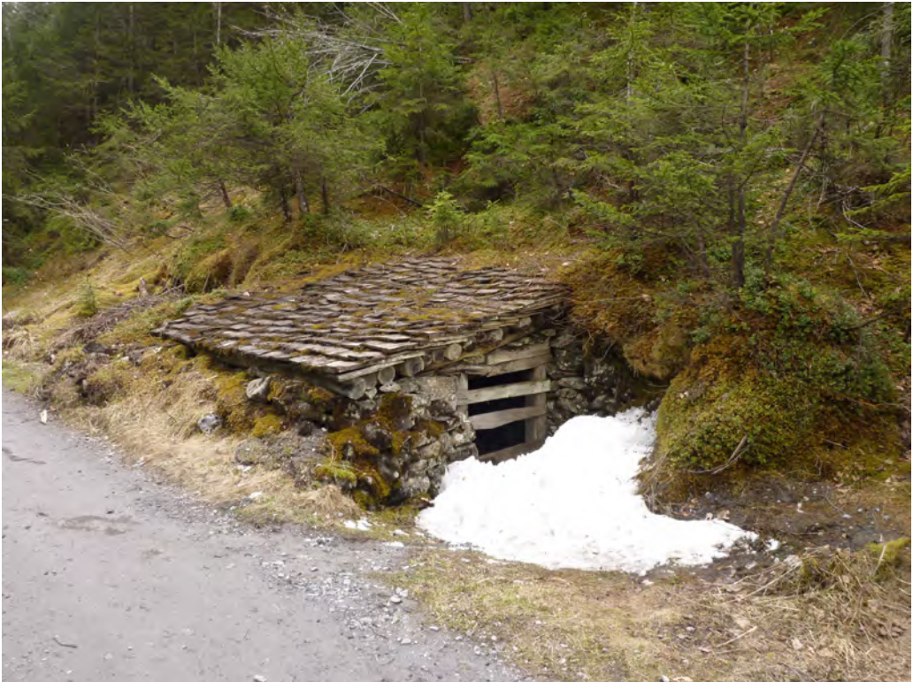
Abb. 2: Kaltkeller am Fusse einer Geröllhalde. Hier werden kühlende Luftströmungen genutzt, um Milch und Fleisch frisch zu halten. Unterschächen, Nitteren, 995 m ü. M. Foto: Benno Furrer, 2010.
