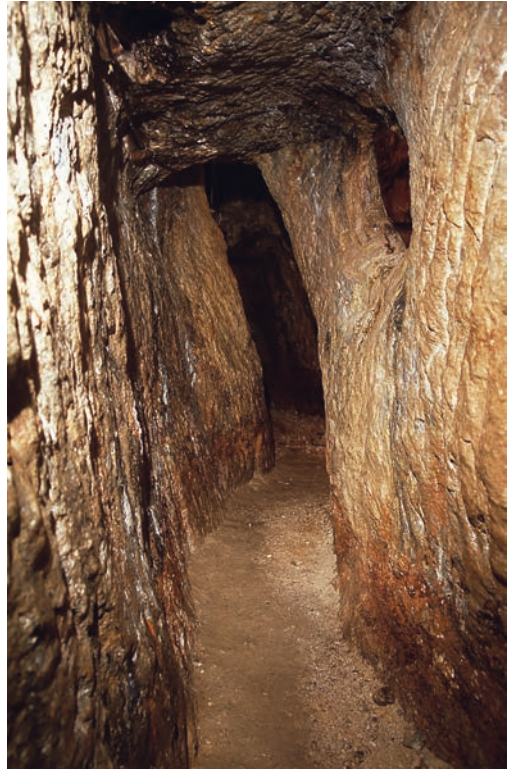
Abb. 50: Mit Schlägel- und Eisenarbeit aufgefahrener Stollen auf der Grube Segen Gottes bei Schnelllingen im Kinzigtal. Wahrscheinlich stammt dieser Grubenbau aus dem 16. Jahrhundert, worauf die kastenartige Form des Stollens hinweist. Foto: Wolfgang Strittmatter, Oberndorf a. N.
