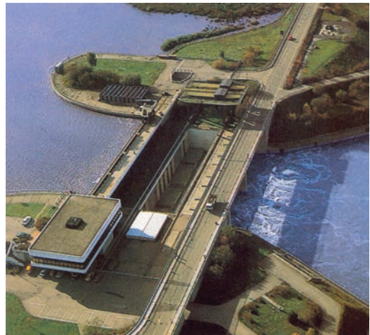
Abb. 22: Wasserkraftwerk Iffezheim-Rhein. Aus: HEINO KALWEIT / WERNER BUCK, Der Rhein unter der Einwirkung des Menschen – Ausbau, Schifffahrt, Wasserwirtschaft , hg. von der Internationalen Kommission für die Hydrologie des Rheingebietes (KHR) (Bericht I, 11), Lelystad 1993, S. 35.
