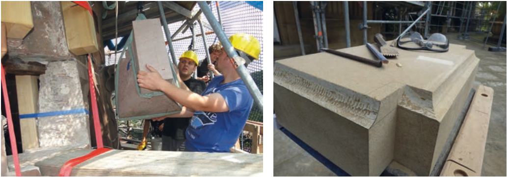
Abb. 30: Heimische Naturwerksteine kommen derzeit vor allem bei Renovierungsarbeiten an Baudenkmalen zum Einsatz, obgleich Qualität und Lagerstättengröße auch eine verstärkte Nutzung in der modernen Architektur zulassen würden: (A) Einbau eines neuen Ecksteins aus Neckartäler Buntsandstein an der Turmpyramide des Freiburger Münsters im Jahr 2013. Foto: Münsterbauverein Freiburg. (B) In Bearbeitung befindliches Werkstück von Güglinger Schilfsandstein vor der Villa Reitzenstein, dem Sitz des baden-württembergischen Ministerpräsidenten. Im Hintergrund sind die Baugerüste zu erkennen, welche zur Durchführung der Renovierungsmaßnahmen unter Verwendung heimischer Naturwerksteine errichtet wurden. Foto: Birgit Kimmig, LGRB, 2014.
