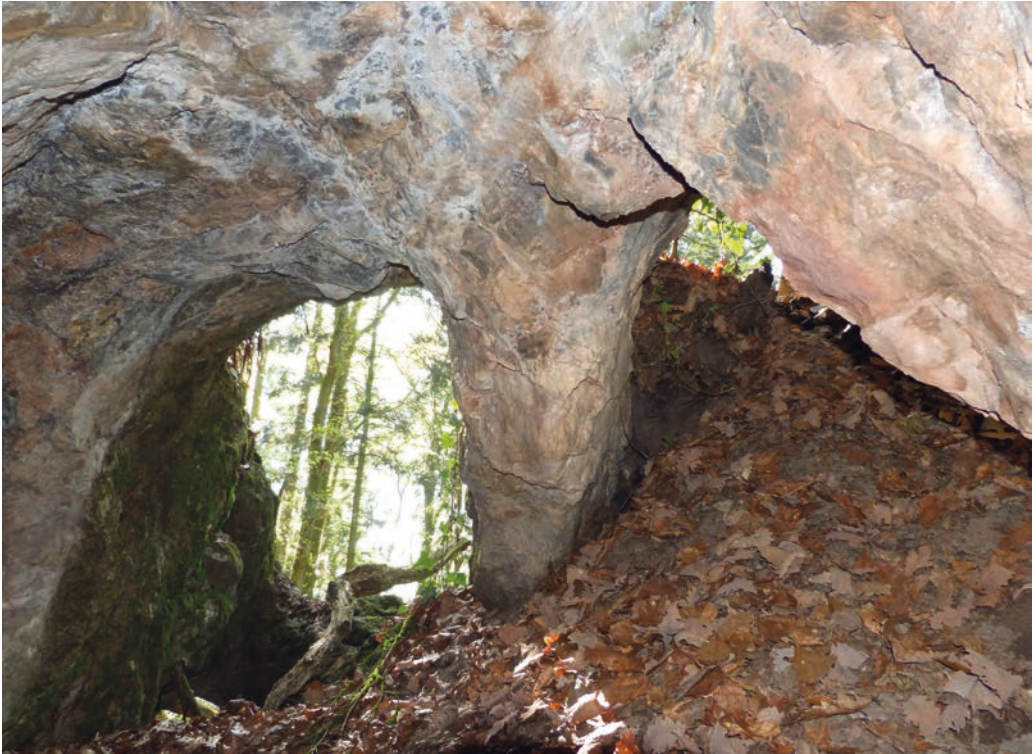
Abb. 46: Am Steilanstieg des Quarzriffs zwischen Badenweiler und Sehringen sind alte Erkundungsstollen (römisch? mittelalterlich?) erhalten, die mit der Methode des Feuerstetzens aufgeföhren wurden; mit eisernen Werkzeugen alleine konnten die extrem zöhnen Quarzgöhnge nicht gelöst werden. Foto: Wolfgang Werner, LGRB.
