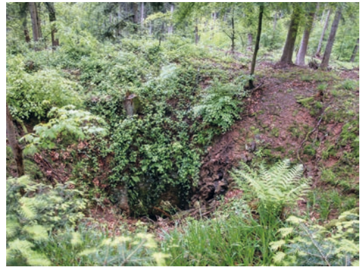
Abb. 3: Eine der schönsten Schachtpingen des Südschwarzwaldes geht auf den ehemaligen Tagschacht der Grube Amalie bei Grunern zurück. Im unteren Bereich des großen Verbruches sind die Stöße des Schachtes noch deutlich zu erkennen (mittlerweile teilweise durch Pflanzen überdeckt). Der Schacht wurde unmittelbar im Erzgang abgeteuft, wie die anstehende Mineralisation am N- und S-Stoß des Schachtes zeigt. Sie führt hier jedoch nur Spuren von Erzen (Fahlerz und Bleiglanz). Foto: Helge Steen, 2013.
