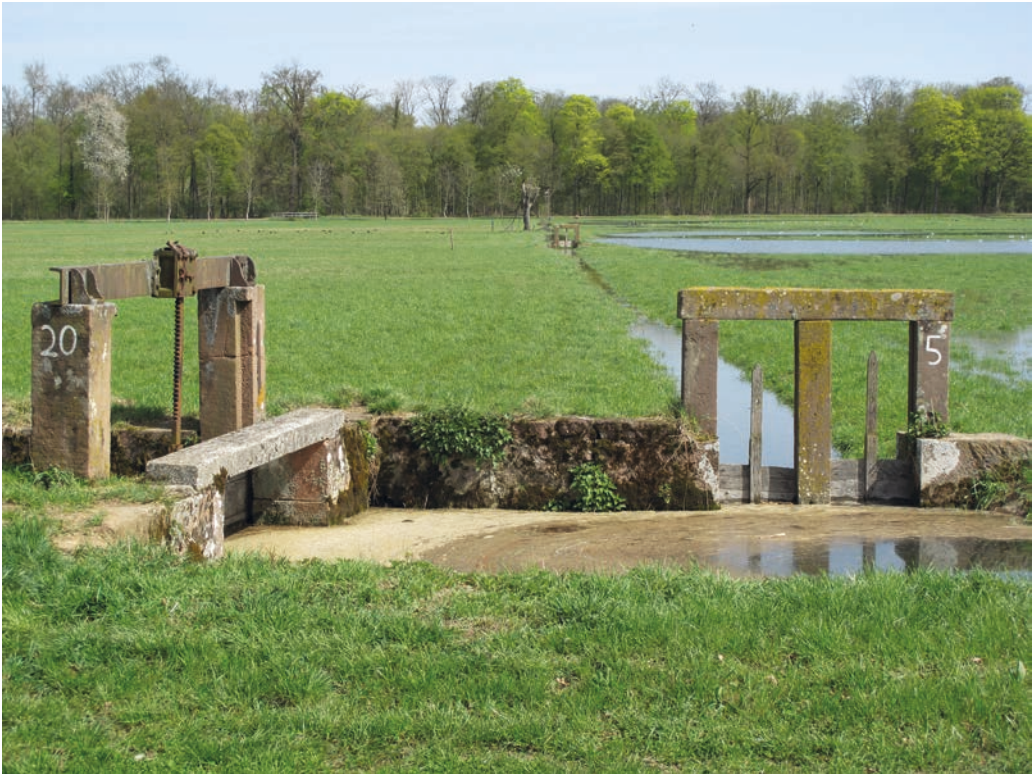
Abb. 17: Traditionelle Bewässerung in den Elzwiesen. Über ein ausgedehntes Kanalsystem wird das Wasser flächenhaft verteilt. Die Wehranlagen im Vordergrund bestehen aus Buntsandstein. Foto: Ingeborg Vonderstrass, 2013.
