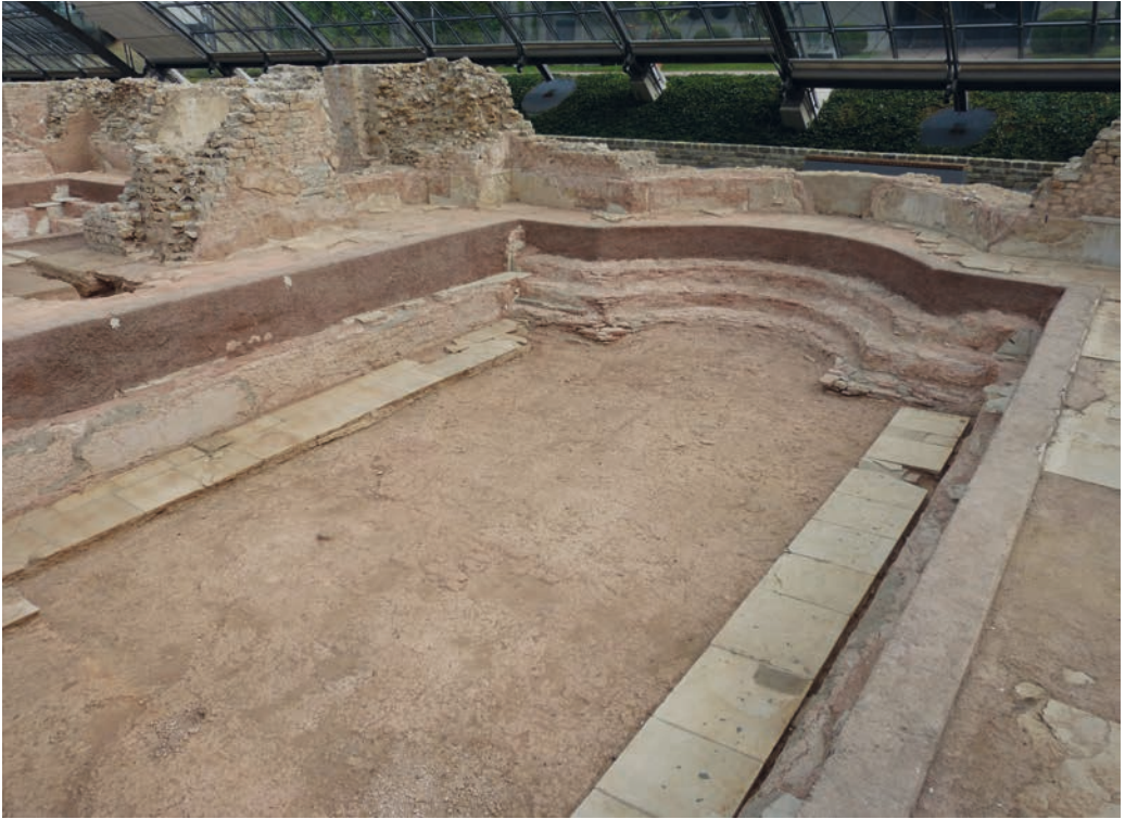
Abb. 43: Ruine des römischen Bads von Badenweiler aus dem 2./3. Jahrhundert n. Chr. Die Mauern sind aus Quadern von Hauptrogenstein errichtet, Bodenplatten sind aus tertiärem Kalksandstein von Britzingen und Niederweiler. Foto: Wolfgang Werner, LGRB.
