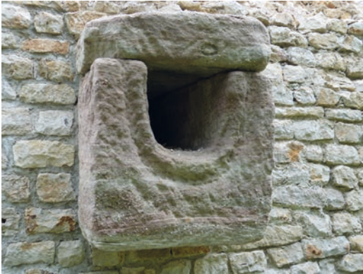
Abb. 44: Abflusssrinne an der Nordmauer des römischen Badegebäudes von Badenweiler. Für das Abflusssystem, durch das das warme, durch Badesätze basische Wasser abgeleitet wurde, verwendete man gezielt Werksteine aus verkieseltem Sandstein. Das Foto zeigt ein Werkstück aus Degerfelder Sandstein, ein stark verkieselter (= durch Quarz gebundener) Quarzsandstein des Buntsandsteins vom Hochrhein. Foto: Wolfgang Werner, LGRB.
