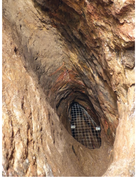
Abb. 47: Mittelalterlicher Grubenbau auf dem Schindlergang, wieder zugänglich im Besuchsbergwerk Teufelsgrund im Münstertal. Die Form des Grubenbaus verrät, dass dieser unter Verwendung des Feuersetz-Verfahrens aufgefahren wurde. Er befindet sich im stark verkieselten Randbereich des Flussspatganges. Den alten Bergleuten war bekannt, dass die meisten Erze im Grenzbereich zwischen Mineralgang und verkieseltem Nebengestein auftreten. Foto: Wolfgang Werner, LGRB.
