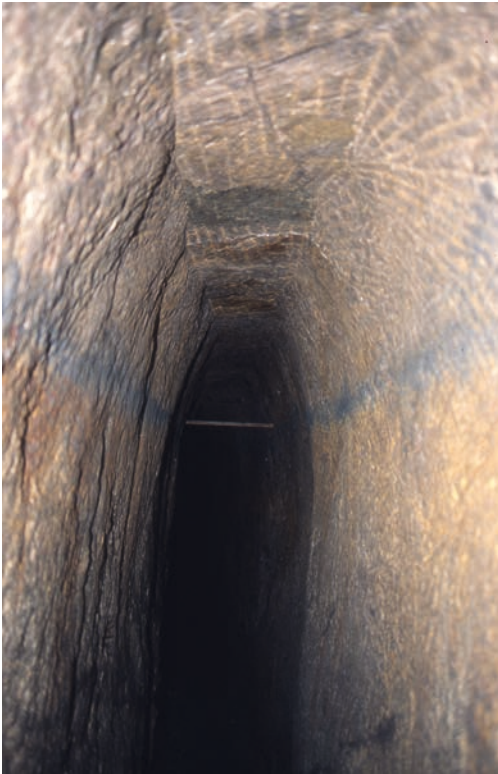
Abb. 51: Mit Schlägel- und Eisenarbeit aufgefahrene Strecke in der Grube St. Louis-Eisenthür bei Sainte-Marie-aux-Mines, Vogesen. Dieser im Granit angelegte Grubenbau ist über zwei Meter hoch und lässt sich wegen der typischen „Sargform“ in das 16./17. Jahrhundert datieren. Das dunkle Band an den Stößen zeigt an, wo die Bretter der Wetterscheider eingebaut waren - eine bemerkenswerte technische Erfindung zum Bewettern langer Strecken ohne zweiten Ausgang. Foto: Wolfgang Werner, LGRB.
