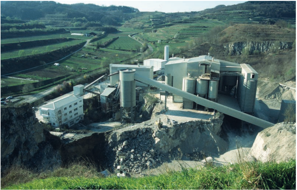
Abb. 27: Im Steinbruch am Ortsrand von Bötzingen steht das zur Verarbeitung und Veredlung von Phonolith nötige Mineralstoffwerk der Fa. H. G. Hauri. Foto: Wolfgang Werner, LGRB.
