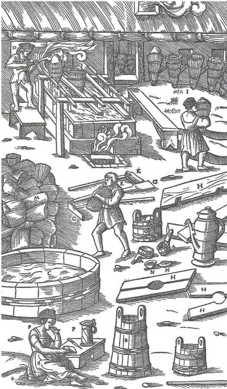
Abb. 6: Siedesalzgewinnung im 16. Jahrhundert mit verschiedenen Personen und Gerätschaften, die zum Sieden gehörten: Schöpfeimer (A), Zuber (B), Bottich (C), Siedemeister (D), Bursche (E), Ehefrau des Siedemeisters (F), Holzspaten (G), Bretter (H), Körbe (I), Schaufel (K), Rechen (L), Stroh (M), Becher (N), Gefäß mit Blut (O), Bierkanne (P). Aus: GEORG AGRICOLA, Vom Bergwerck XII Bücher (De re metallica), Basel 1556 (Faksimile Nachdruck, Leipzig 1985), S. 450–491, hier S. 474.
