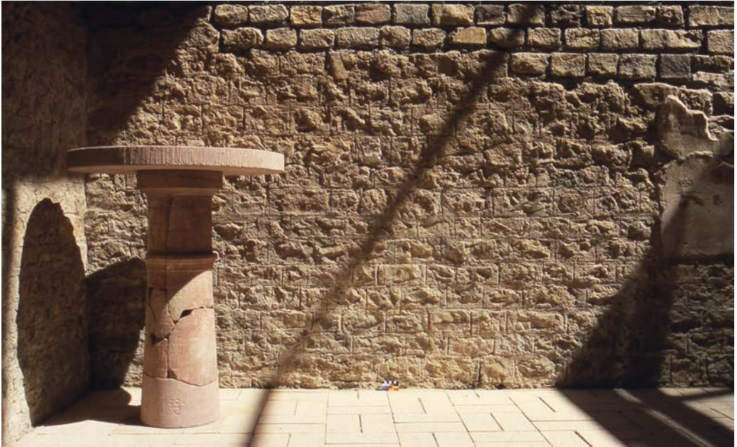
Abb. 45: Mauer aus Haupttrogenstein-Quadern mit typisch römischem Fugenstrich im Keller der Villa Urbana von Heitersheim. Im Mörtel dieses Landguts konnten Pochsande von römischen Bergwerken (Sulzburg? Badenweiler?) nachgewiesen werden. Foto: Wolfgang Werner, LGRB.
