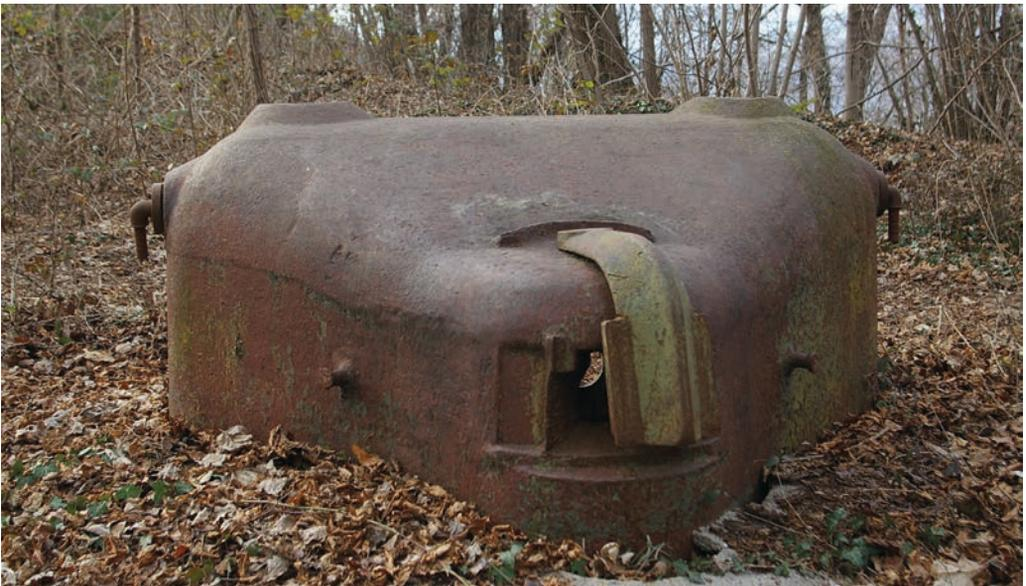
Abb. 9: Für die Infanterie wurden neben Erdstellungen auch „Panzerwachtürme“ eingebaut, aus denen heraus ein Maschinengewehr eingesetzt werden konnte. Mit Rädern mobilgemacht, konnten sie an Schwerpunkten der Front aufgestellt werden. Foto: Florian Brouwers.
