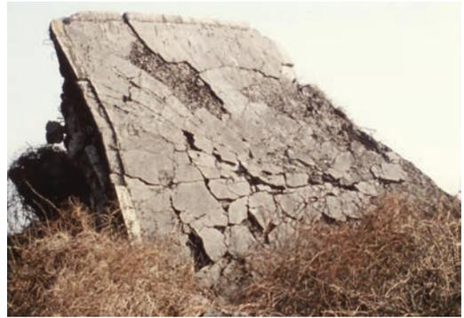
Abb. 11: An dieser gesprengten Bunkerdecke ist aufgrund des Verlaufs der Risse die Lage der Sprengladung gut erkennbar. Foto: Friedrich Wein.
