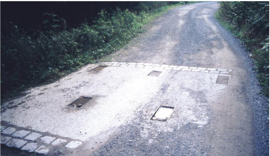
Abb. 3: Mit solchen bodenebenen Steckschienensperren wurden die Wege und Straßen, die von Westen her durch die Sperrstellen am westlichen Schwarzwaldrand hindurchführten, ausgestattet. Sie konnten im Bedarfsfall mit H-Profil-Trägern ausgestattet werden, die die Straße wirkungsvoll gegen Fahrzeuge und leichte Panzer sperren konnten. Foto: Friedrich Wein.
