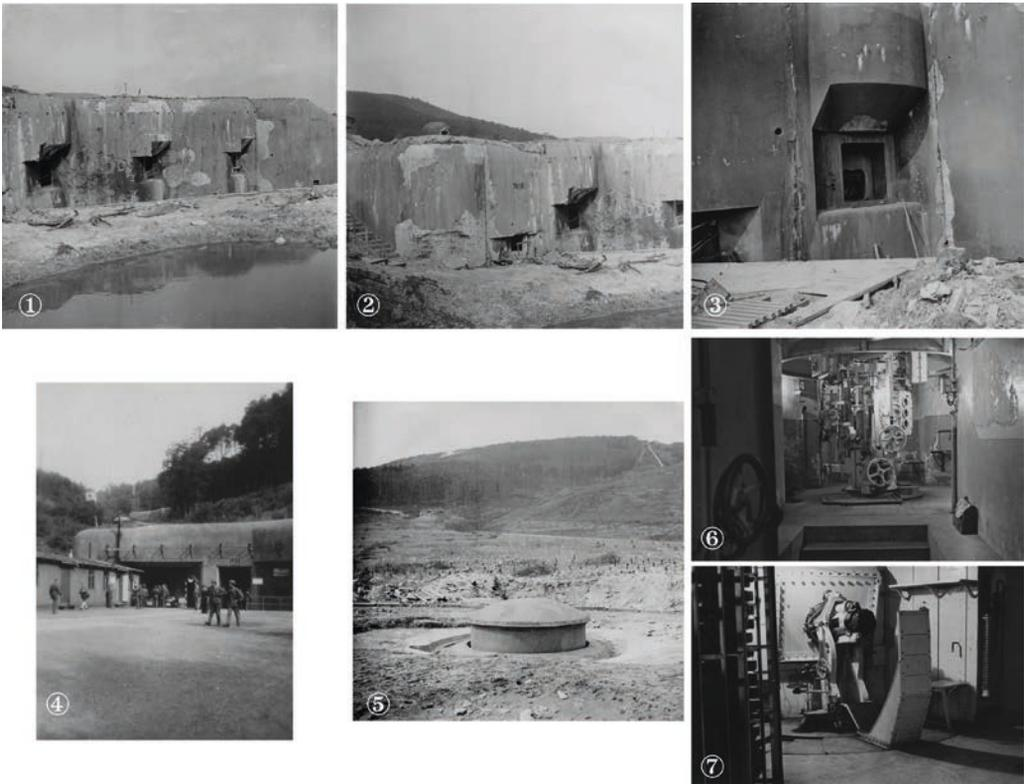
Abb. 10: Großes Artilleriewerk von Hochwald Ost: Kasematte für drei Kanonen Kaliber 7,5 cm Modell 1929 (1–2); Munitionseingang (4); Block 1 – Kasematte mit Geschütz 13,5 cm und Turmgeschütz 13,5 cm (3 und 5). Die Innenansichten stammen aus dem großen Artilleriewerk Hackenberg (Lorraine), aber die Anordnung ist ähnlich: versenkbarer Geschützturm (6) und 7,5 cm Kanone in einer Artilleriekasematte (7).
