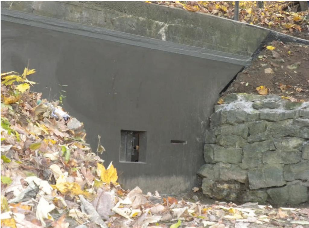
Abb. 1: Eine Schartenplatte für den Einsatz eines Maschinengewehrs (MG) eines Bunkers der Neckar-Enz-Stellung. Foto: Friedrich Wein.
