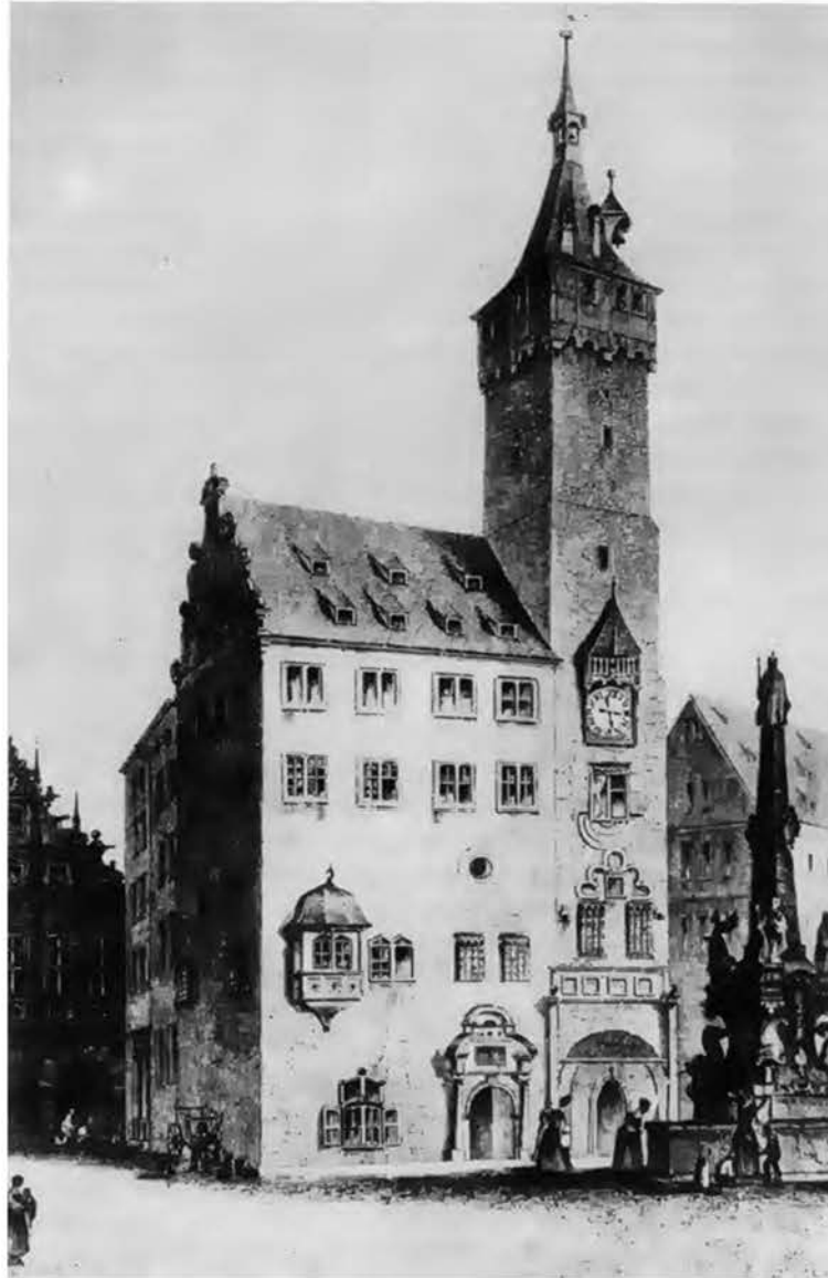
Abb. 34 Würzburg, Grafeneckarturm (Rathaus); zu beachten sind die beiden unteren Geschosse, die auf eine Laube für das hier abgehaltene Schultheißengericht hindeuten. (Heller, Der Grafeneckart, Abb. 8)
