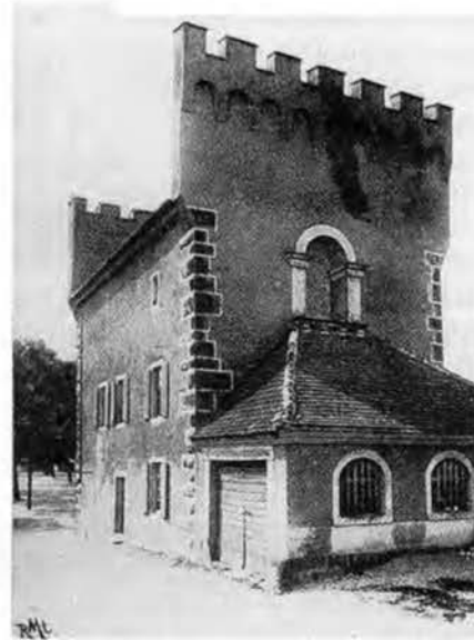
Abb. 26 Breisach, wiederaufgebauter Radbrunnenturm nach dem von Arnold abgeänderten Entwurf von Nordosten um 1900. Der nördliche Anbau anstelle der jüngeren Gerichtslaube (dann Hauptwache, Feuerwehrremise). (Freiburger Blätter für Wandern und Reisen, Nr. 27 vom 6. Dez. 1906, S. 3)
