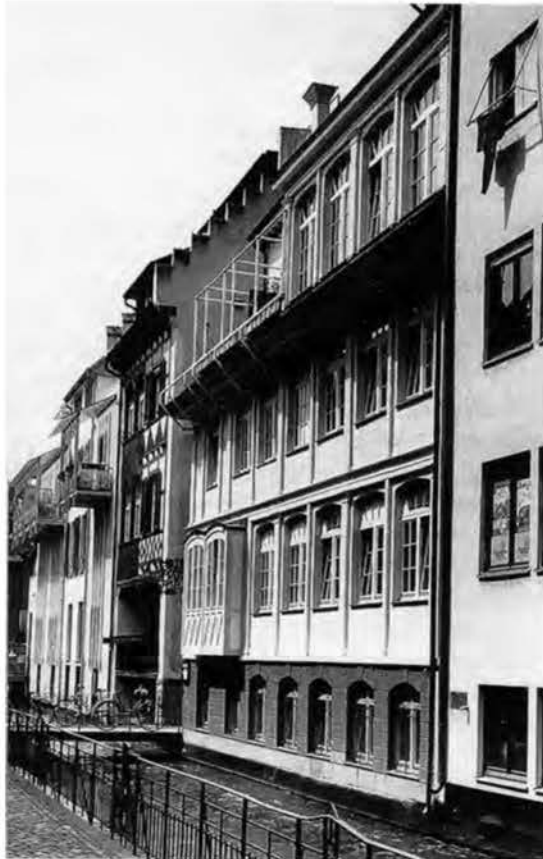
Abb. 4 Rückseite des Hauses Nr. 65 (Gerberau 22) am Gewerbekanal. (Foto: Stadtarchiv Freiburg)
