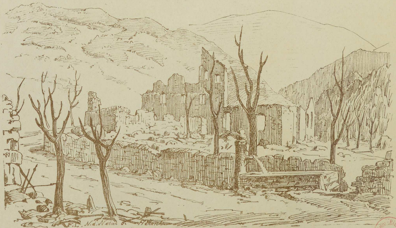
Bürstenfabrik. (nach dem Brande.)
