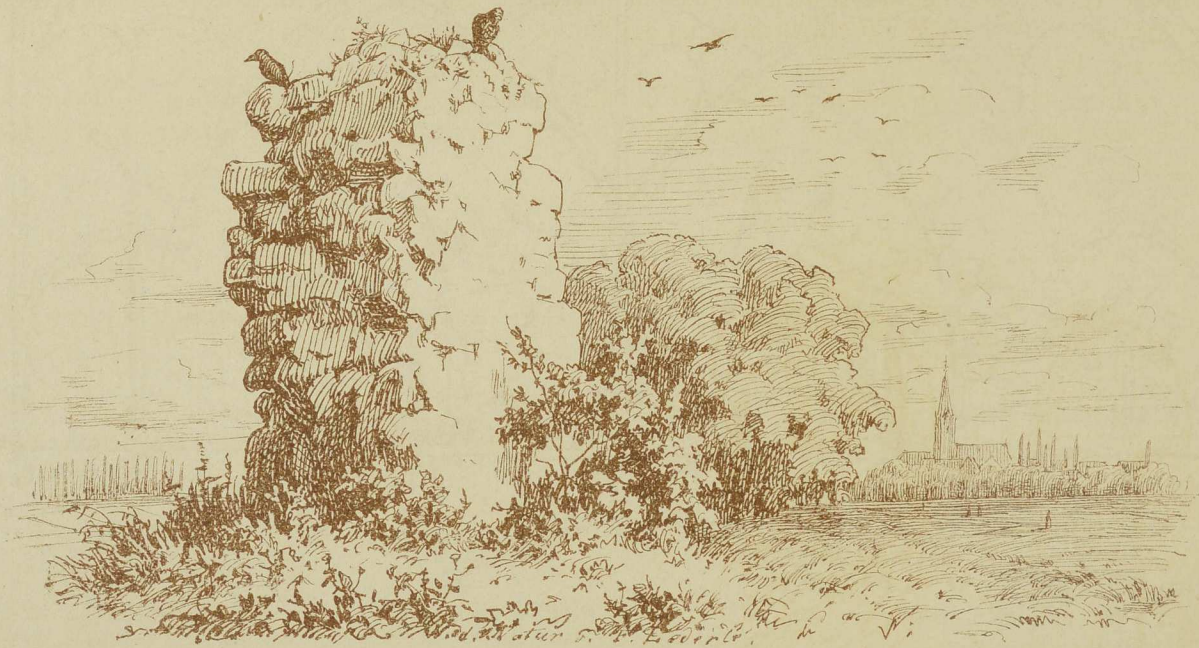
Letzter Ueberrest des ehemaligen Klosters Gutenuau b. Neuenburg.
