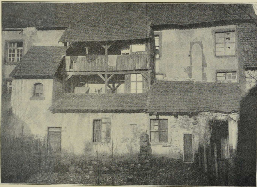
Wonnenthal, Nordseite des Klosterhofes mit Rest eines gotischen Fensters der alten Kirche.
