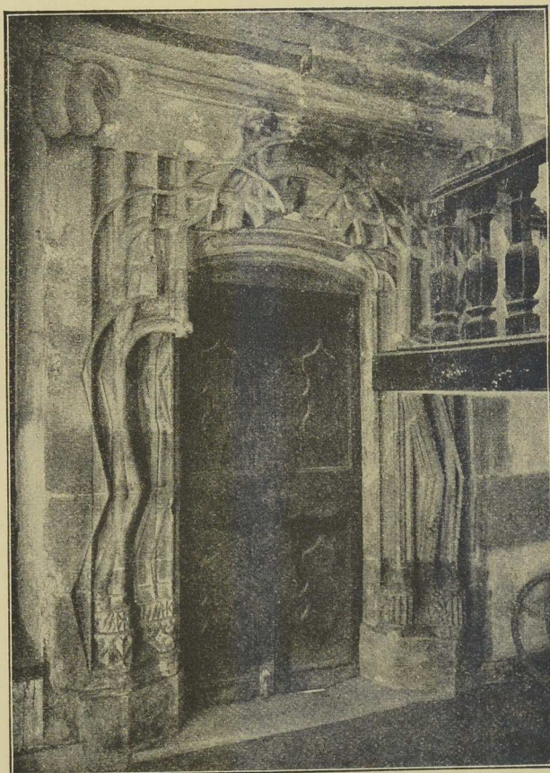
Abb. 6. Portal des Erdgeschosses.
