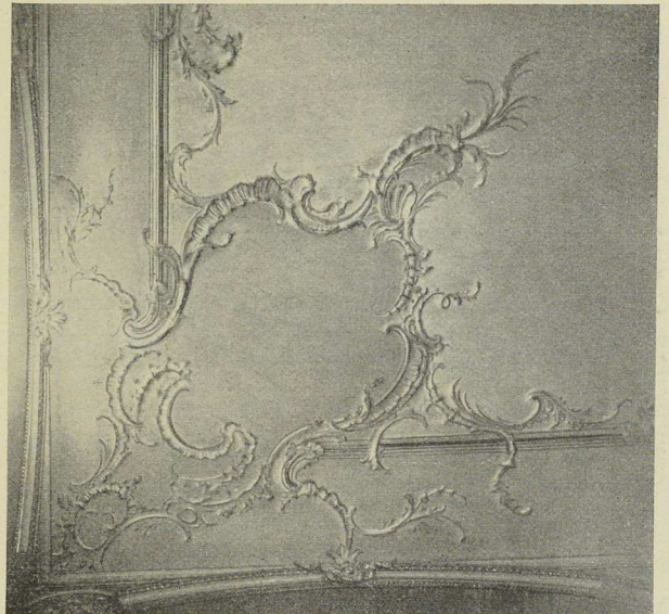
Abb. 27. Eckstück der Decke im alten Ratsaal.
