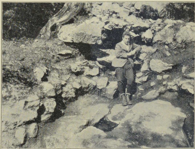
Blick in das Innere des Nordturmes. Im Vordergrund die Felsplatte mit der rechteckigen Vertiefung. Im Hintergrund Gußmauerwerk. Phot. H. Kay.
