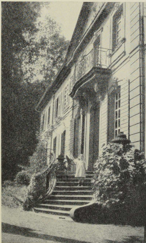
Fassade mit Freitreppe und Balkon
