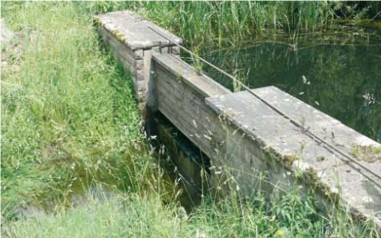
b) Einstau-Bauwerk im NSG „Lappen und Eiderbachgraben“. – Foto: L. MURMANN-KRISTEN.
