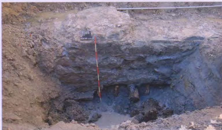
Abb. 29: Auf dem Grundstück Ecke Bodanstr./ Bahnhofplatz freigelegtes Fundament der Stadelhofener Stadtmauer auf einer Holzkonstruktion aus Pfosten sowie quer- und längs verlaufenden Hölzern (Kreisarchäologie Konstanz, Foto: J. Hald).
