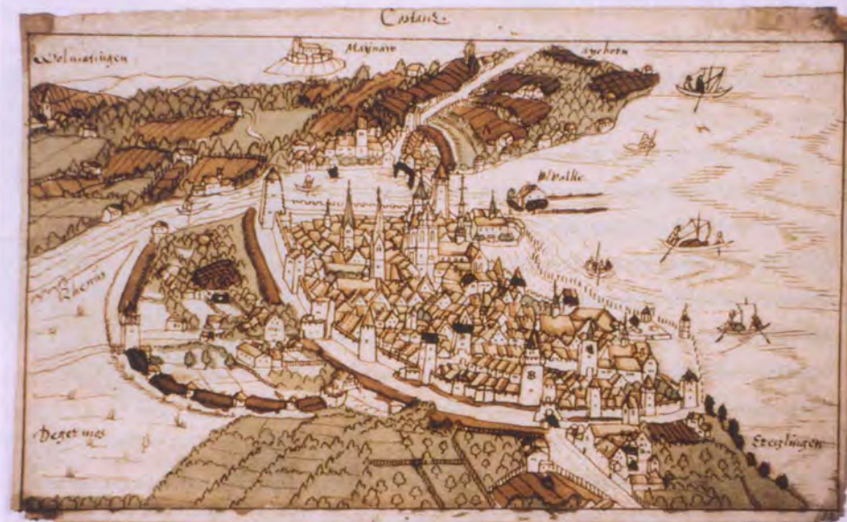
Abb. 35: Die Federzeichnung aus dem Jahre 1575 zeigt den Zustand der Befestigungen vor dem Bau von Schanzen. Stadelhofen im Süden wirkt fortifikatorisch wie ein Teil der Altstadt, während Petershausen jenseits des Rheins und das Paradies links im Bild deutlich schwächer befestigt sind (Rosgartenmuseum Konstanz Inv. Nr. T. 142).
