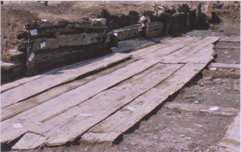
Abb. 9: Holzwanndung des Mühlkanals aus Phase 2, Blick nach Nordwesten. Mittig in der Holzwanndung verbautes Holzbrett mit regelmäßigen Bohrungen (vermutlich ein Rechen). Die Holzwanndung ist mit Pfosten fixiert, an diese angepasst der Kanalboden aus Holzbrettern, der auf hölzernen Unterzügen aufliegt.
