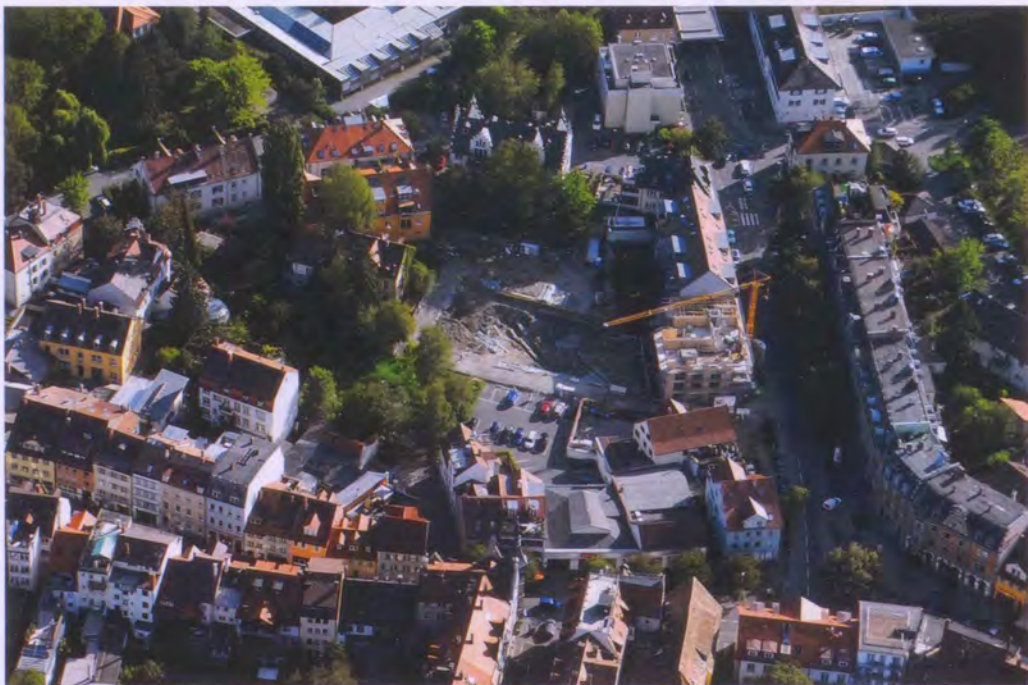
Abb. 1: Luftbild des Quartiers zwischen Emmishofer Straße (rechts), Kreuzlinger Straße (unten) und Schwedenschanze (oben), Blick nach Süden. Die gebogene Form der Schwedenschanze zeichnet noch den Verlauf der Stadelhofer Befestigung nach; Standort des Emmishofer Tores etwa im Bereich des Zebrastreifens auf der Emmishofer Straße. Zentral im Bild: Grabungsfläche im Hinterhofbereich der Emmishofer Straße 3; der vordere Bereich – hier im Bau – wurde im Herbst 2008 archäologisch untersucht (Gerry Mayr – Luftfoto, www.gerry.as ).
