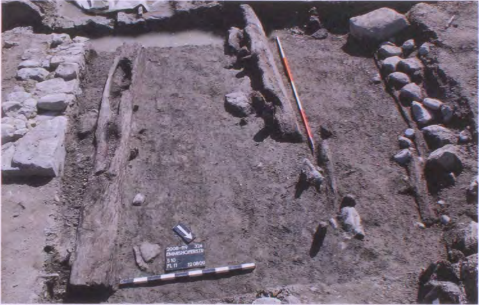
Abb. 4: Ältere Mühle, Blick nach Süden. Mittig: Mühlkanal aus massiven Holzbalken bestehend; in der Kanalmitte Abdrücke eines Holzbretterbodens. Rechts: Freifluter mit Bachbefestigung. Ganz links: Reste der östlichen Mühlkanalmauer aus Phase 2.
