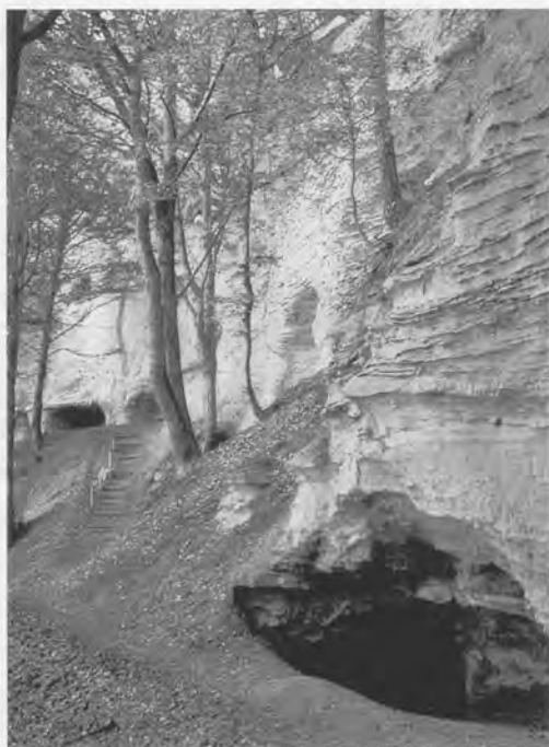
Abb. 17: Die Felswand von Süden mit der Mündung des »Ganges« (Untere Höhle 1) rechts im Vordergrund. Links hinten sieht man den Eingang in die Untere Höhle 3 (Foto: R. Keller)
