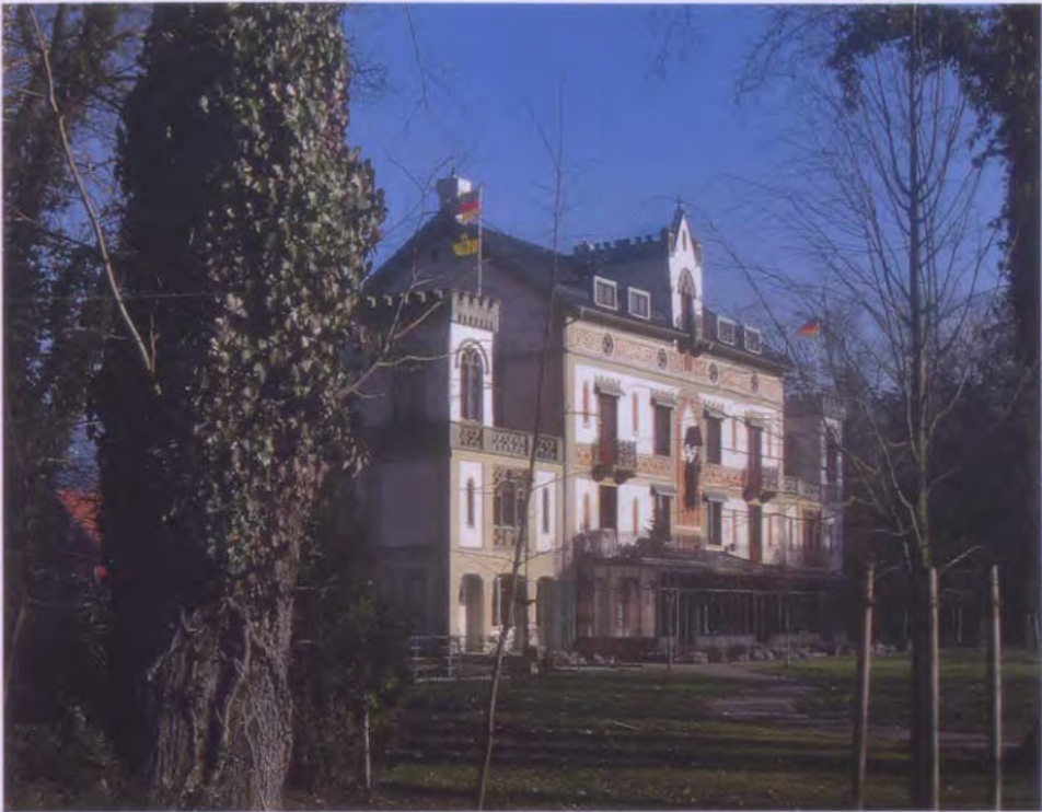
Abb. 3: Ansicht von Nordwesten
