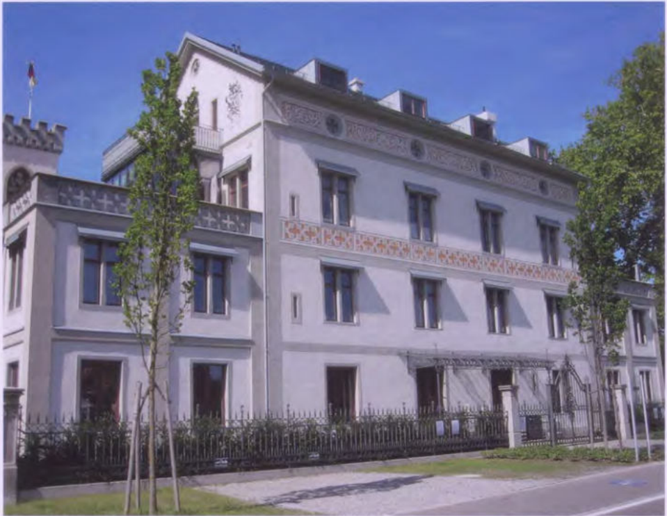
Abb. 2: Ansicht von der Straße nach der Sanierung
