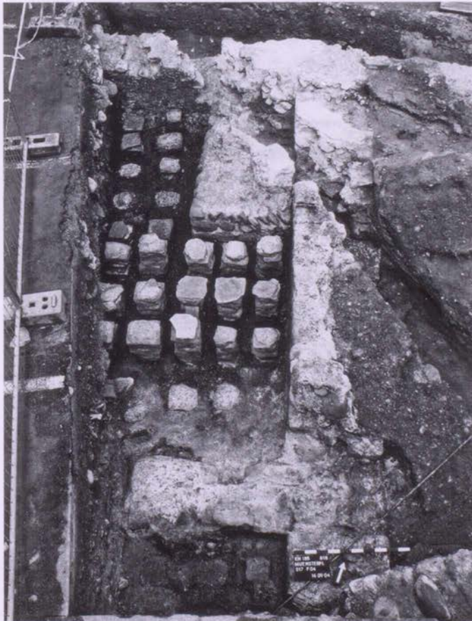
Abb. 12: Spätrömisches Kastell. Badegebäude. Nördlicher Bereich des Tepidariums mit den noch in voller Höhe erhaltenen Pfeilern der renovierten Fußbodenheizung.
