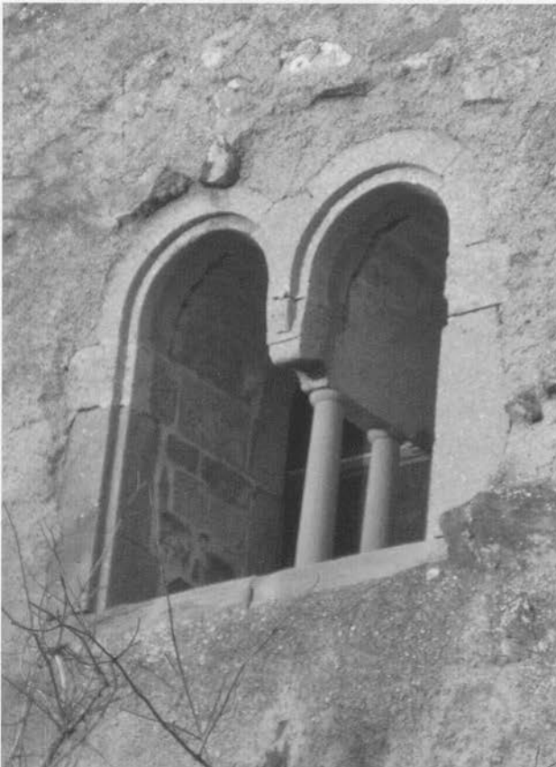
Abb. 6: Friedingen, Burg. Hauptburg, Ringmauer, angeblich »romantisches« Fenster, tatsächlich aber von 1919 (Aufnahme Losse 2007)
