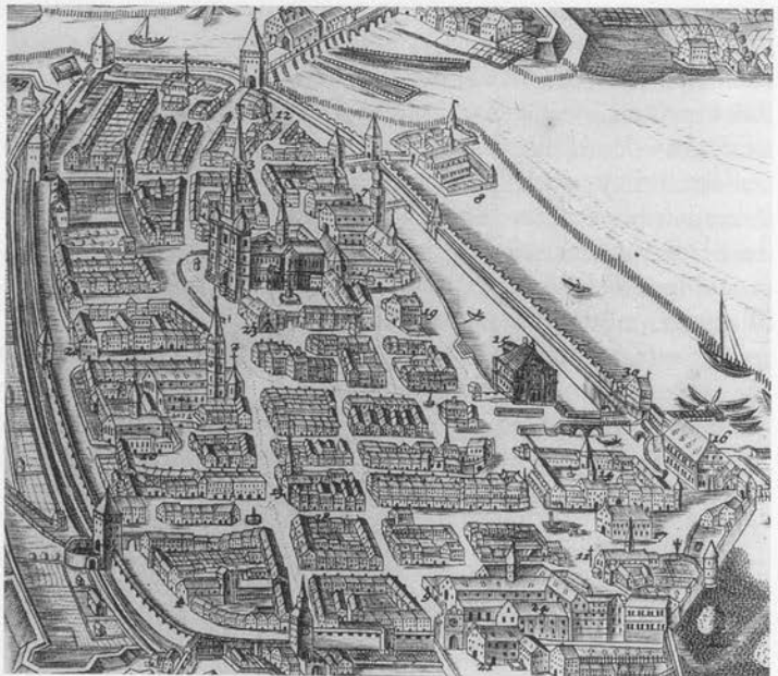
Abb. 20 Kupferstich von Johann Friedrich Speth, 1733. Obwohl die Stadtansicht im Detail stark schematisiert ist, lassen sich doch bei dem Viertel hinter dem Dachreiter der Augustinerkirche (vorne rechts) langgestreckte zum See orientierte Parzellen und kleinere an der Rückseite der Marktstätte liegende Liegenschaften erkennen.
