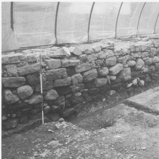
Abb. 6 Die südliche Kaimauer, Blick von Westen.
