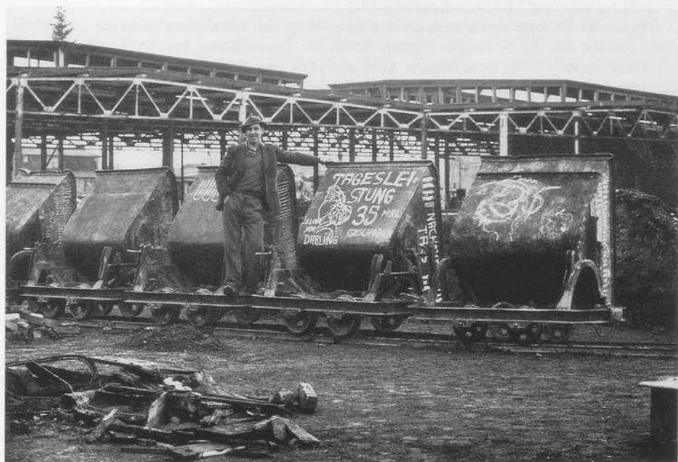
Abb. 5 Enttrümmerung in der Zahnradfabrik Friedrichshafen 1947. Jeder nach dem Krieg in die Firma zurückkehrende Mitarbeiter einschließlich der leitenden Angestellten war verpflichtet, zuerst einige Wochen an der Enttrümmerung des Firmengeländes mitzuwirken.
