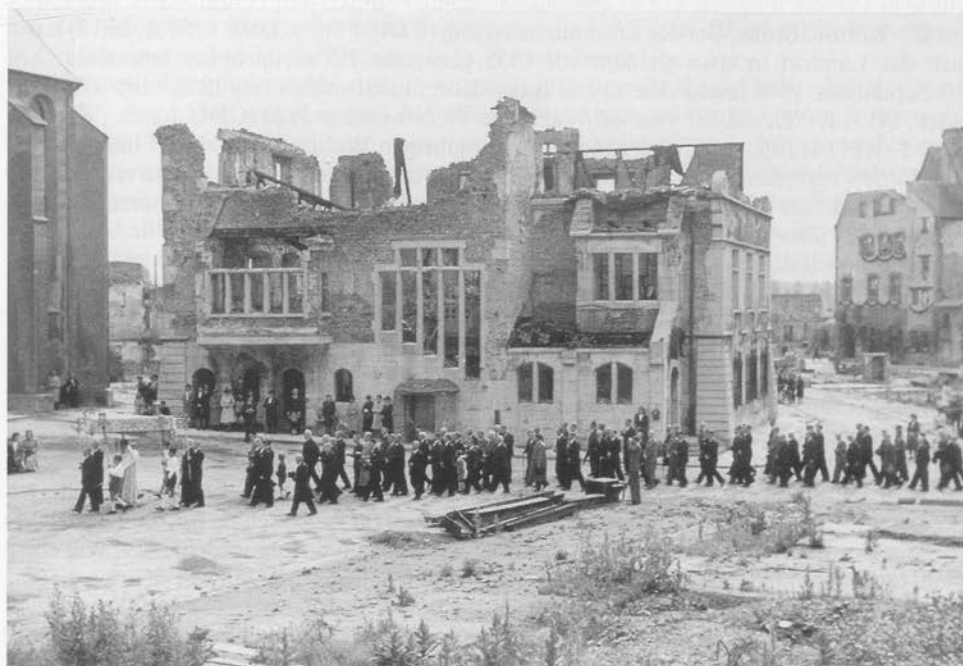
Abb. 1 Fronleichnamsprozession am 16. Juni 1949 durch die zerstörte, schon weitgehend von Trümmern freigeräumte Altstadt von Friedrichshafen. In der Bildmitte die Rathausruine, am linken Bildrand die wiederhergestellte Nikolauskirche, am rechten Rand das schwer beschädigte Gebäude der Hauptpost.
