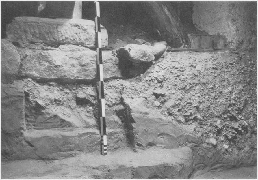
Abb. 18 Konstanz, Münster-Krypta, Schnitt 1975 am südöstl. Säulenfuß, Nordprofil von Süd. Links oben Säule mit Basisstein und flachem Fundament, darunter Baugrube, nach rechts abfallend der gewachsene Boden, darüber kiesige Auffüllung.
