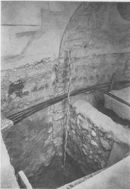
Abb. 15 Westwand mit ottonischer Rundbogenöffnung, rechts: spätgotische Gruft, links: ottonischer Wandverputz mit Holzanslag und Bodenabriß, von Südosten.
