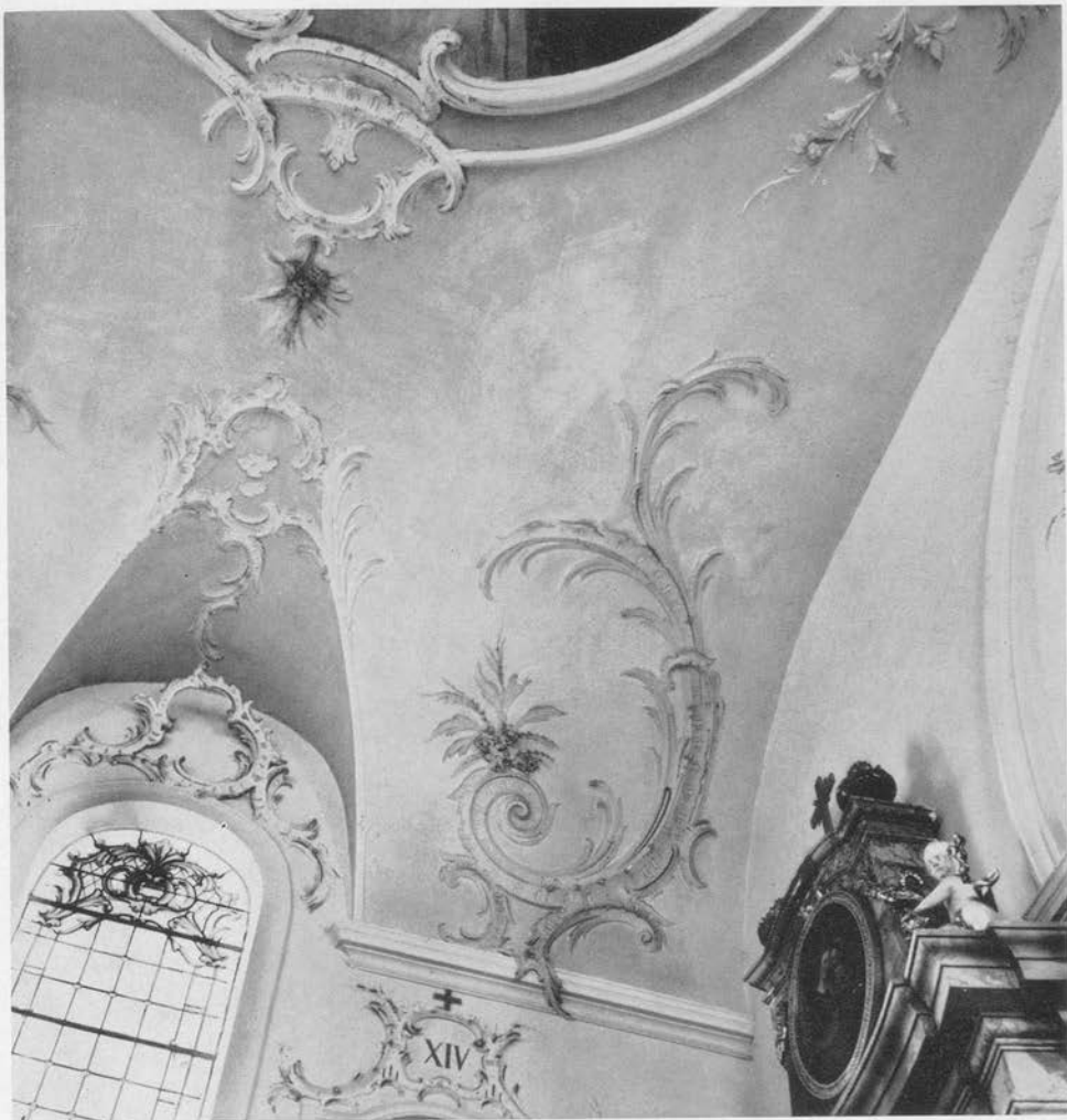
49 Schiff, Nordost-Ecke, Stuckdetail
