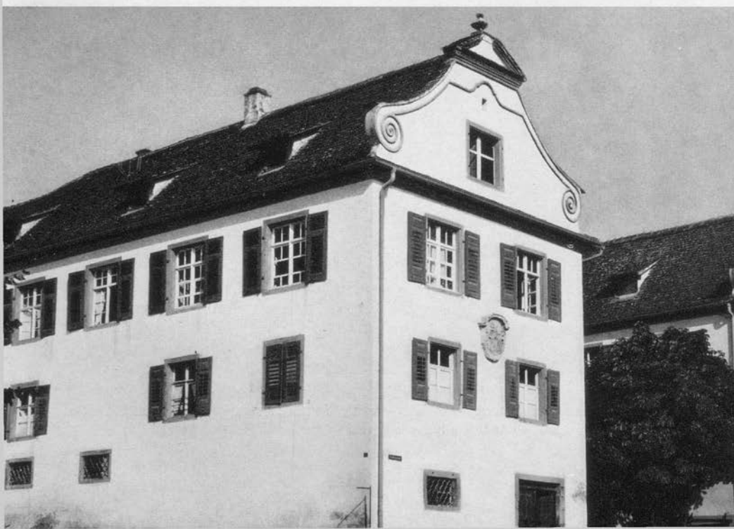
Abb. 4: Schussenrieder Pflughof in Hagnau am Bodensee, erbaut 1736/38 von Jakob Emele, umgebaut zur Wein- und Speisewirtschaft, jetzt Wohnung von Bauunternehmer Wilhelm Model und Schreiner Oskar Ehrlenspiel mit Fremdenpension
