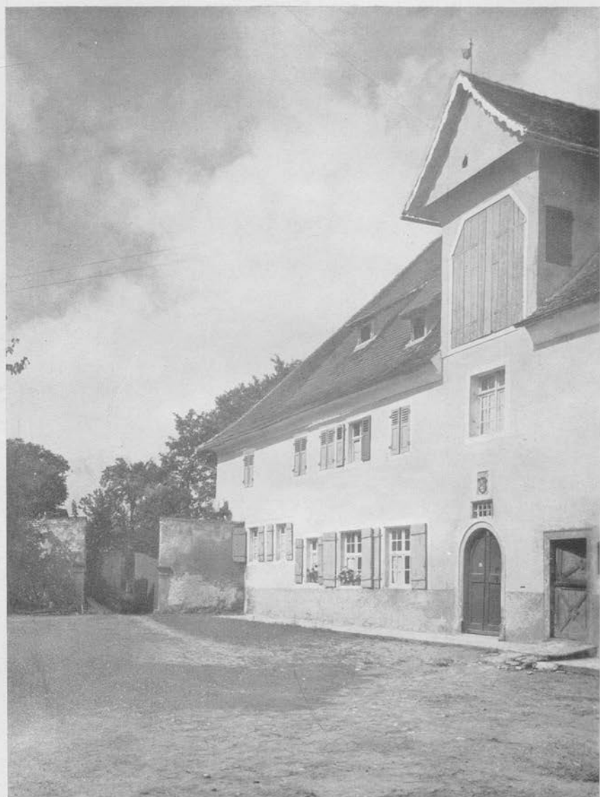
Noch bestehender Teil des Klosters Löwental mit Pforte und Wappen darüber sowie Eingang zum Klostergarten.
